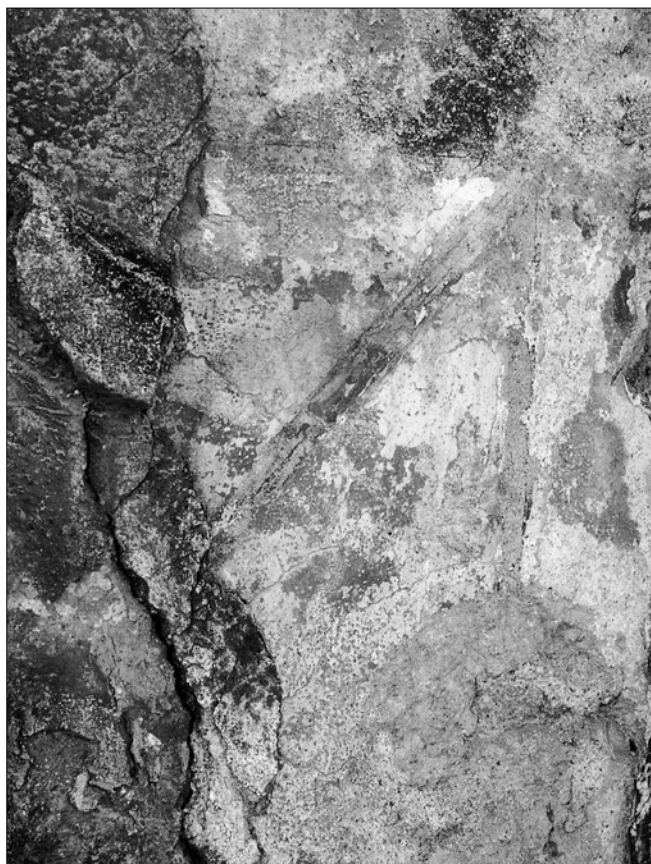
Obr. 10: Český Krumlov, dům čp. 32, severní průčelí, pozdně středověké rámování okenního otvoru ve 2. patře červenou linkou, později přetřené červenou šambránou renesanční barevnosti.
