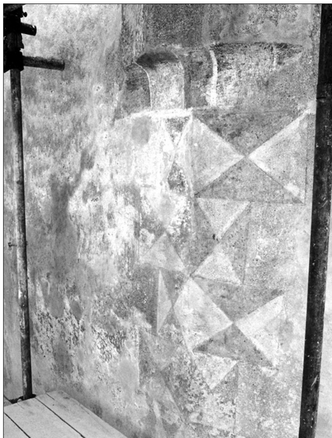
Obr. 8: Český Krumlov, dům čp. 32, severozápadní nároží, malované pozdně středověké nároží prostrádaných dělek po restaurátorském zásahu.
