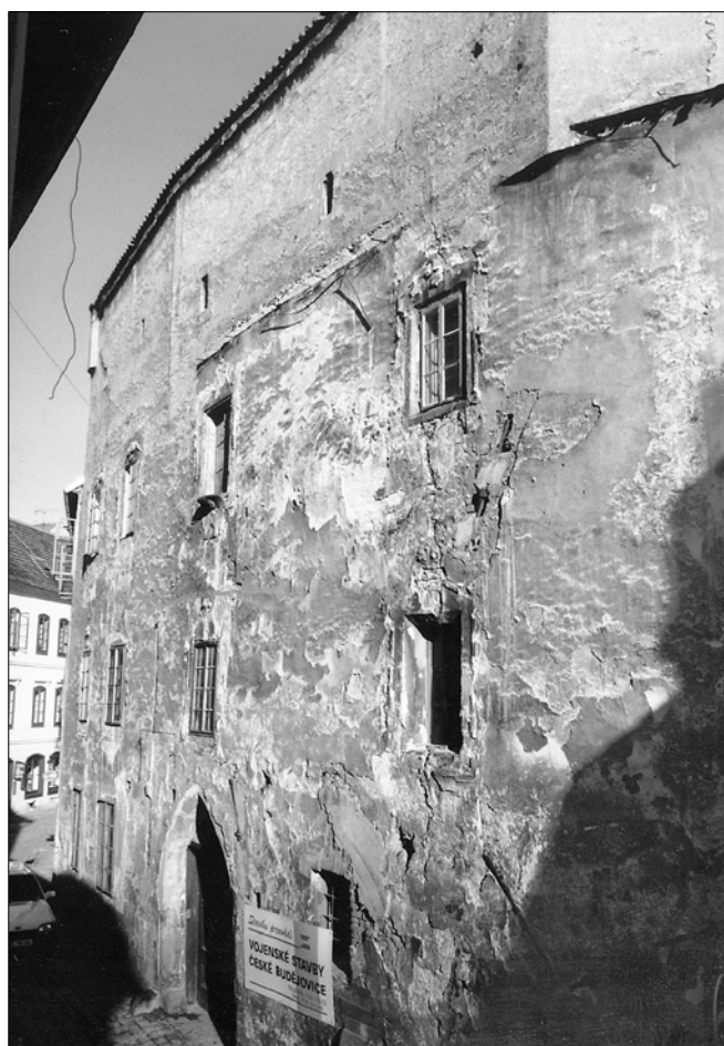
Obr. 3: Český Krumlov, dům čp. 32, severní průčelí v r. 1997 před opravou fasád.
