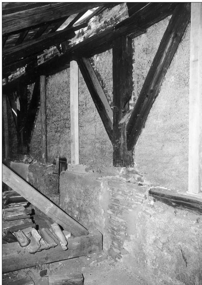
Obr. 2, 3: Český Krumlov. Varianty zavětrování konstrukce stolice pultového krovu u atiky domu čp. 32 - symetrické dvojice pásků a (chybějící) vzpěra do vazného trámu v severní části objektu a průběžná nesymetrická diagonála na západní straně jižní části budovy.
