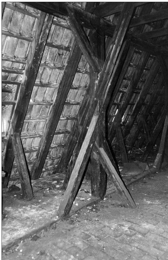
Obr. 5: Krov severního křídla konventu klarisek - detail sloupku stojaté stolice v severozápadní části.
