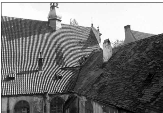
Obr. 22: Pohled na západní část kostela Božího těla, napravo střecha zá-padního křídla konventu klarisek.
