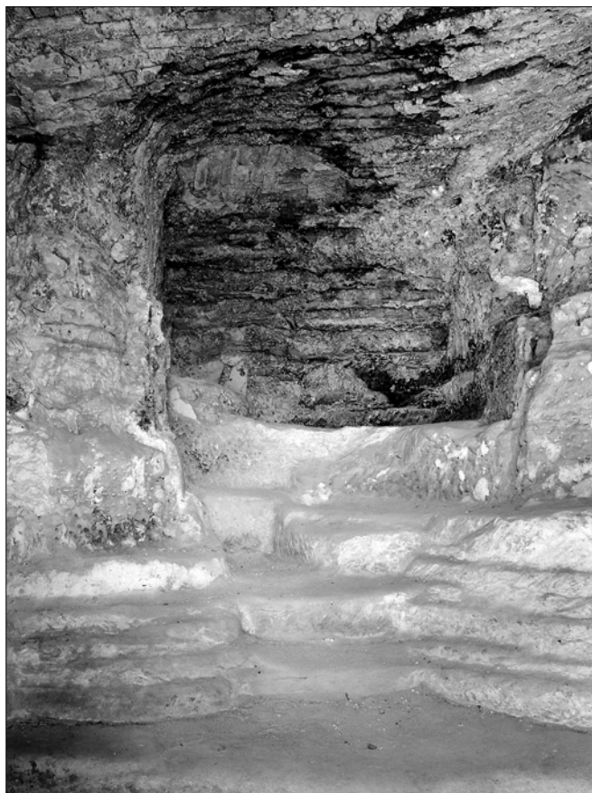
Obr. 7: Sloup, Boží hrob křížové cesty, upravený ve třetí etapě osídlení na grottu (foto R. Kursaj).
