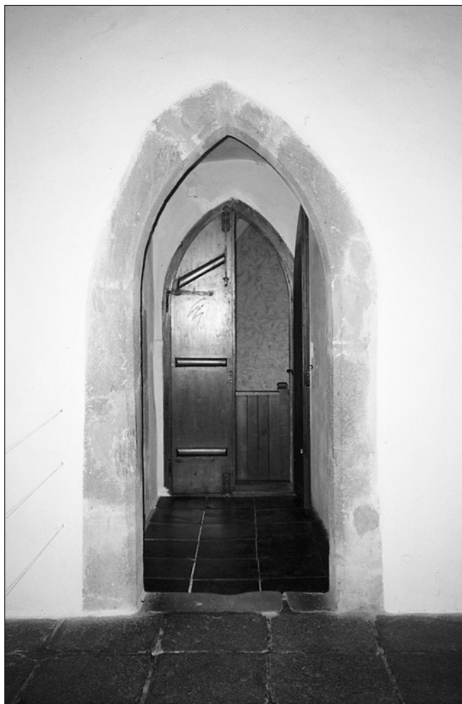
Obr. 10: Hrad Zvíkov, Hlízová věž, vnitřní portálek do interiéru prvního patra (foto J. Varhaník, 1999).
