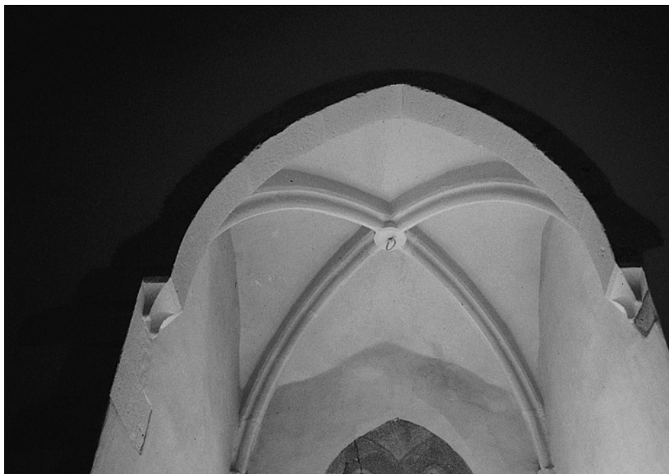
Obr. 12. Hrad Zvíkov, žebrově klenutý výklenek v západní zdi prvního patra Hlízové věže (foto J. Varhaník, 1999).
