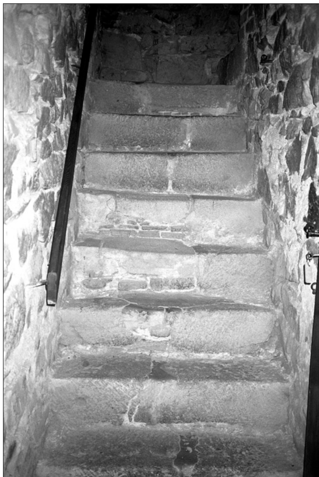
Obr. 14: Hrad Zvíkov, Hlízová věž, spodní rameno schodiště v síle zdiva (foto J. Varhaník, 1999).
