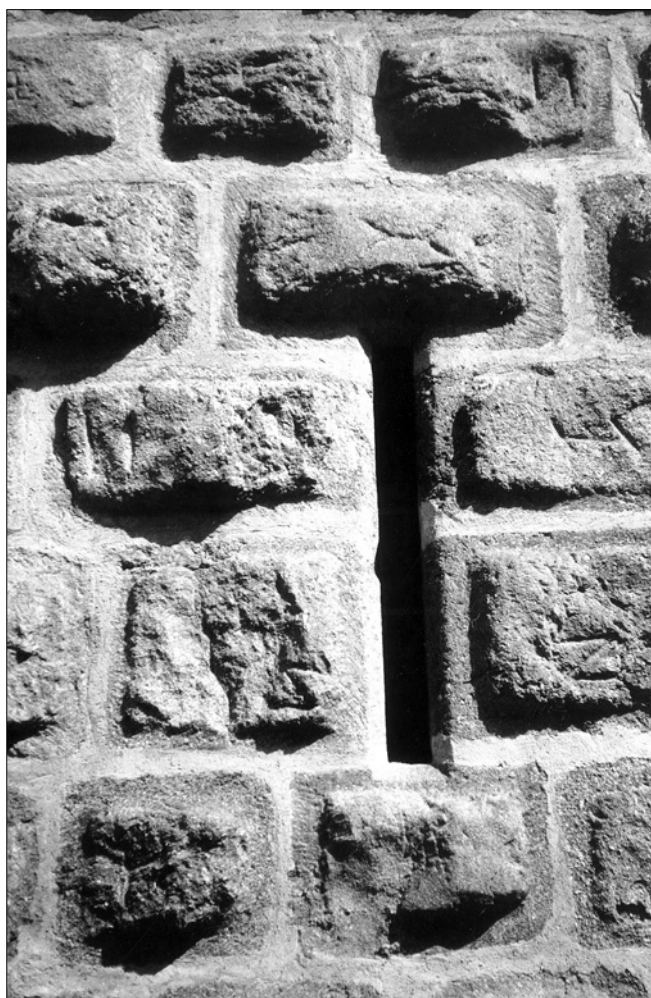
Obr. 5: Hrad Zvíkov, ostění střílny pro lučištníky v přízemí Hlízové věže. Bosované kvádry obkladu jsou většinou opatřeny kamenickými značkami (foto J. Varhaník, 1995).
