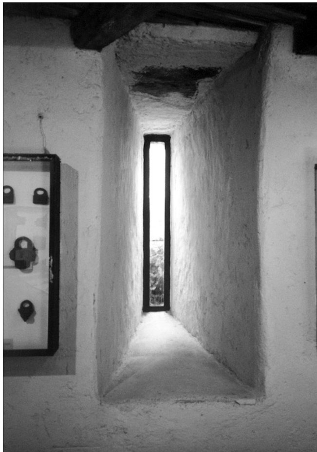
Obr. 21: Hrad Lockenhaus, Burgenland, Rakousko, špaleta střílny pro lučištníky z interiéru prvního patra donjonu (foto J. Varhaník, 1998).
