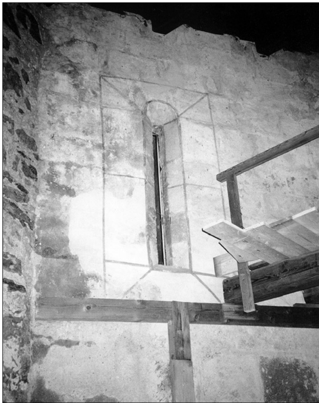
Obr. 20: Hrad Lockenhaus, Burgenland, Rakousko, ostění střílny pro lučištníky v prvním patře donjonu (foto J. Varhaník, 1998).
