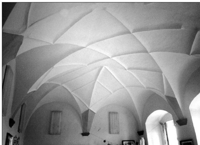
Obr. 14: Hrad Sádek, klenba sálu jižního sálu v patře východního křídla.
