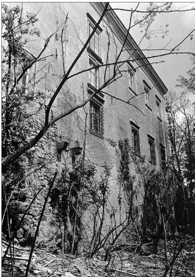
Obr. 8: Hrad Sádek, východní část jižního průčelí s krakorci arkýře.
