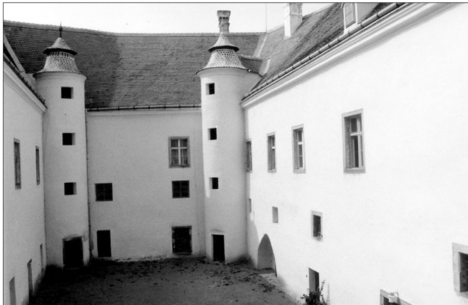
Obr. 6: Hrad Sádka, průhled nádvořím k západu (stav v roce 1983).
