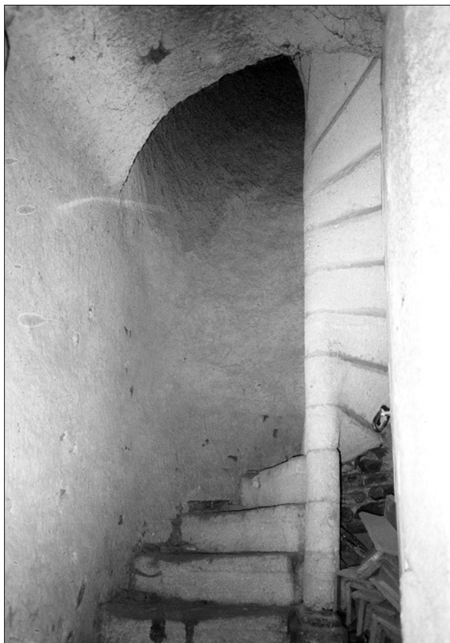
Obr. 12: Hrad Sádek, vřeteno schodiště břítové věže.
