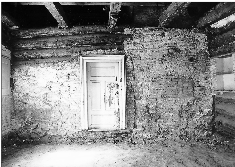
Obr. 12: Saky, čp. 2, hlavní dům, světnice, stěna při síni a černé kuchyni (foto J. Anderle).
