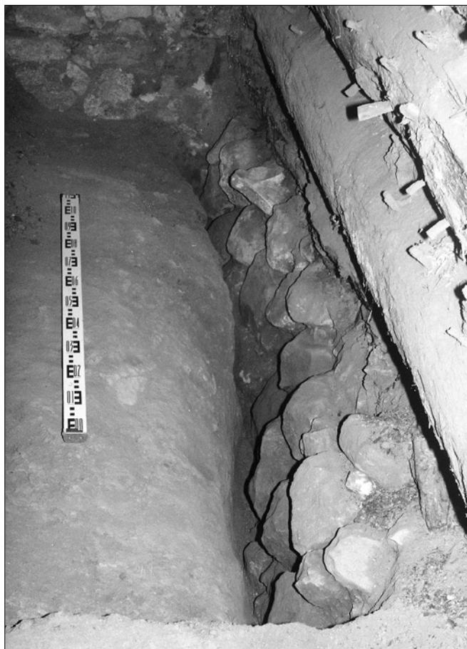
Obr. 22: Saky, čp. 2, základový vkop pod západní částí severozápadní stěny srubu, pohled od východu, viz obr. 21:I (foto M. Ježek, 1999).
