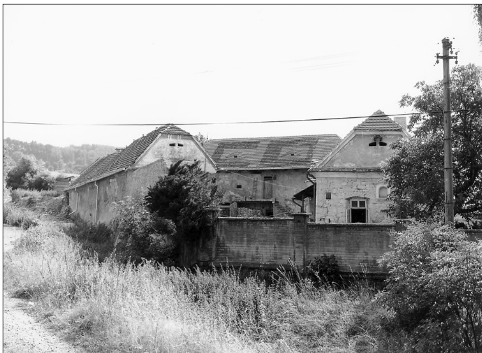
Obr. 5: Saky čp. 2, celkový pohled od severovýchodu (foto J. Klápště).
