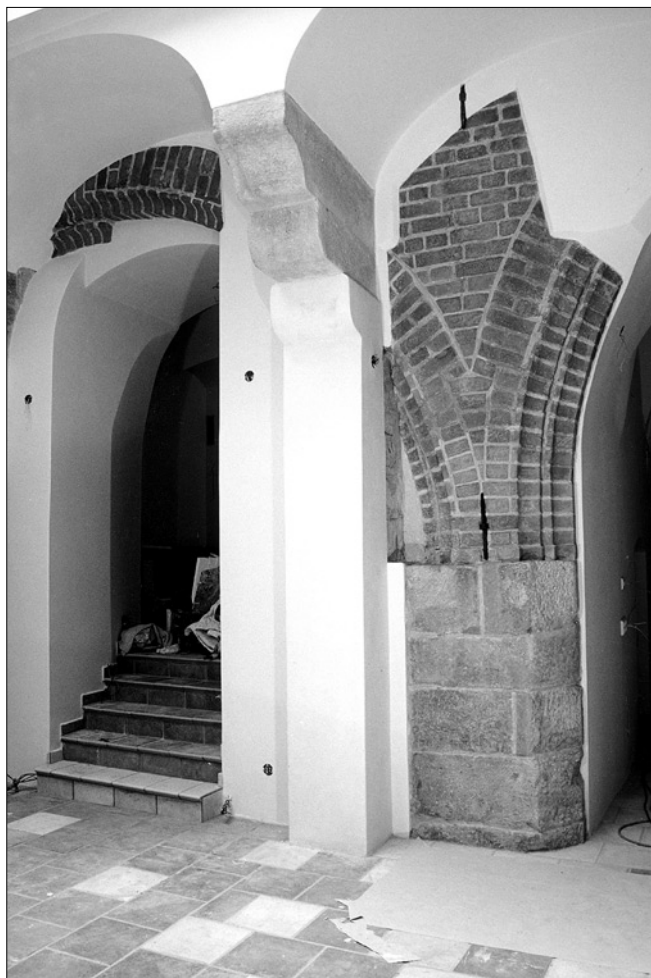
Obr. 6: Praha 1 - Staré Město, Staroměstské náměstí čp. 549/I. Restaurovaná gotická nádvorní partie z cihlových tvarovek na pískovcovém soklu s dvěma kotvami kleštinové výztuže a kamennými krakorcí pozdně gotické či renesanční fáze. Pohled od jihovýchodu (foto P. Cajthaml).
