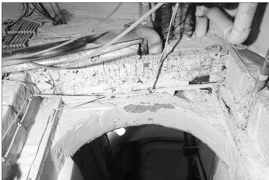
Obr. 4: Praha 1 - Staré Město, Staroměstské náměstí čp. 549/I. Částečně ztrouchnivělá fošna překladu románské portálové niky ve spodním podlaží a horní část románského portálu. Pohled od severu (foto J. Hlavatý).
