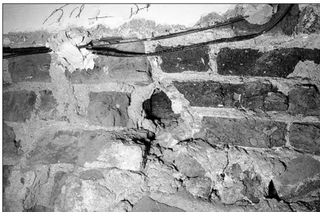
Obr. 7: Praha 1 - Staré Město, Staroměstské náměstí čp. 549/I. Východní stěna gotické stavby uprostřed parcely. V otvoru uprostřed patrný trám kleštinové výztuže. Vlevo od něj gotické cihlové zdivo, vpravo mladší cihly. Pohled od východu (foto P. Cajthaml).
