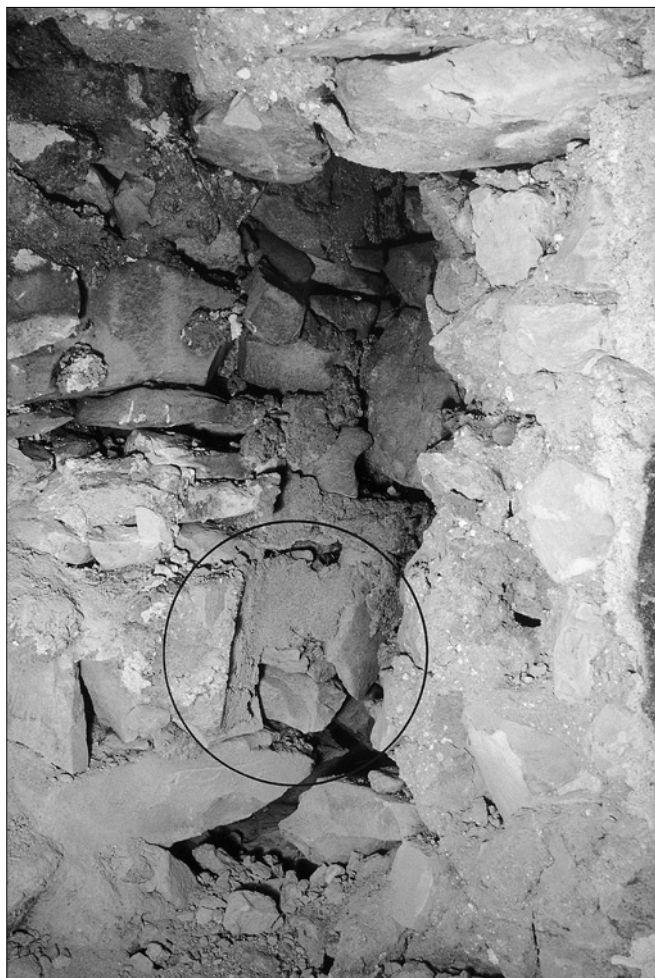
Obr. 5: Praha 1 - Staré Město, Staroměstské náměstí čp. 549/I. Rub základové části románského zdiva sousedního objektu čp. 548/I. V kroužku otisk obliny pažení výkopu pro stavbu. Pohled od jihovýchodu (foto P. Cajthaml).
