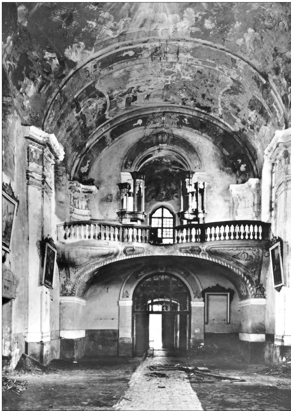
Obr. 4: Radnice (okr. Karlovy Vary), kostel sv. Jakuba Většího. Pohled ke kůru (foto SÚPP, Vl. Fyman, 1957).
