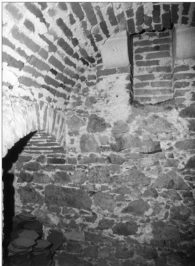
Obr. 17: Roupov hrad, severní bašta předhradí, 1. patro, čelo černé kuchyně s ústím dymníku.
