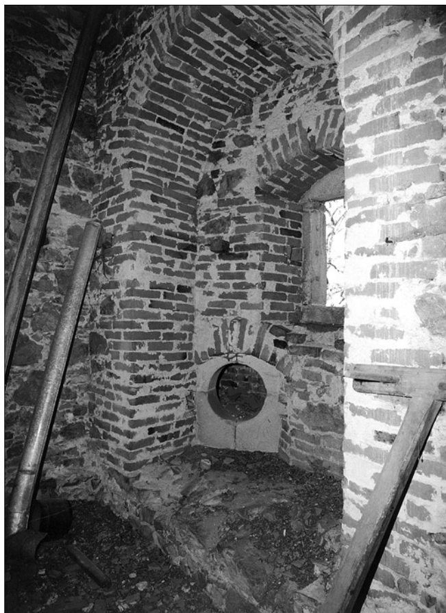
Obr. 18: Roupov hrad, severní bašta předhradí, 1. patro, nika s oknem a zazděnou střílnou při západním koutu.
