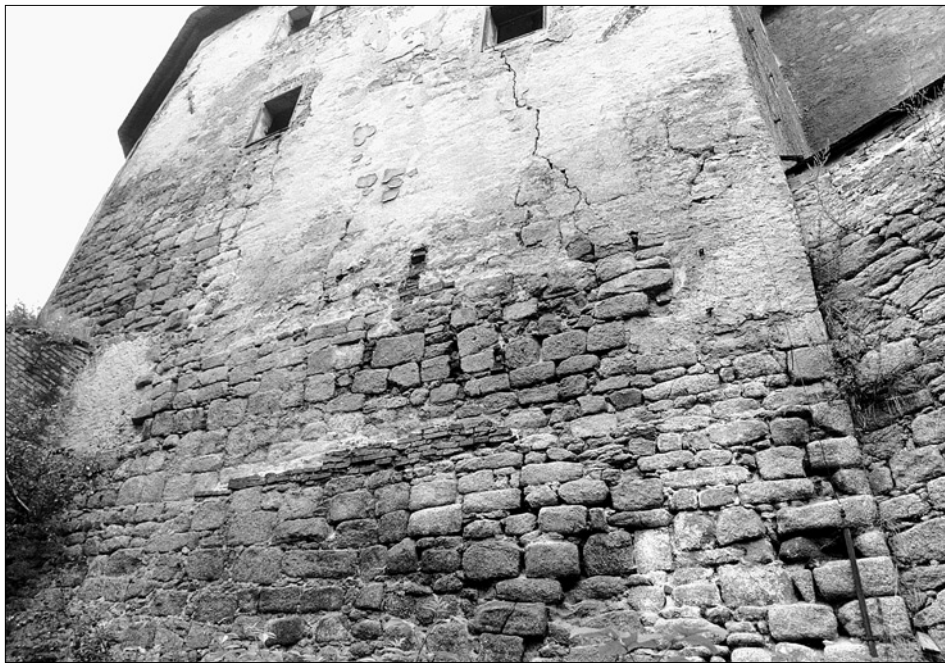
Obr. 7: Skalná (okr. Cheb), pohled na hrad Vildštejn od severu, při nároží přezděné románské zdivo (foto T. Karel, 1999).
