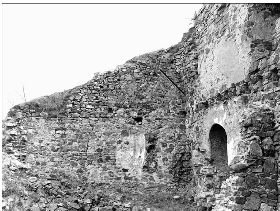
Obr. 16: Valdek, vnitřní strana východní zdi paláce s pozůstatky krbu a druhotně nadezděného štítu (zvýrazněno přímkou). Vlevo návaznost nádvoří zdi (foto autor, 1999).
