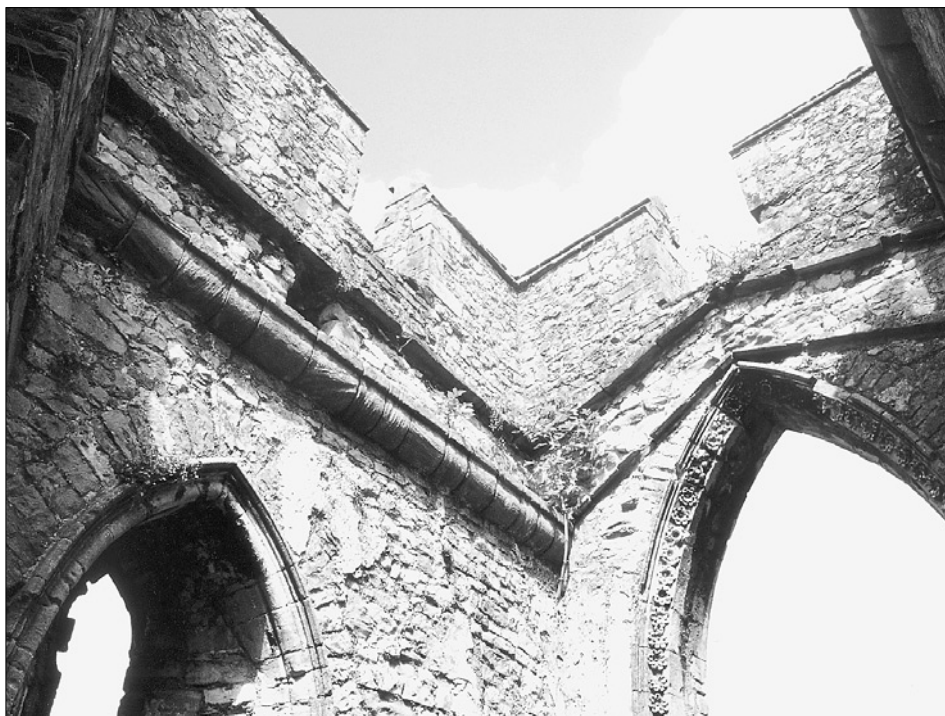
Obr. 25: Chepstow, hrad ve Walesu. Kaple Martenovy věže, 80. - 90. léta 13. století. Detail říms klenby a nízké střechy, přiložené přímo k cimbuří (foto autor, 2000).
