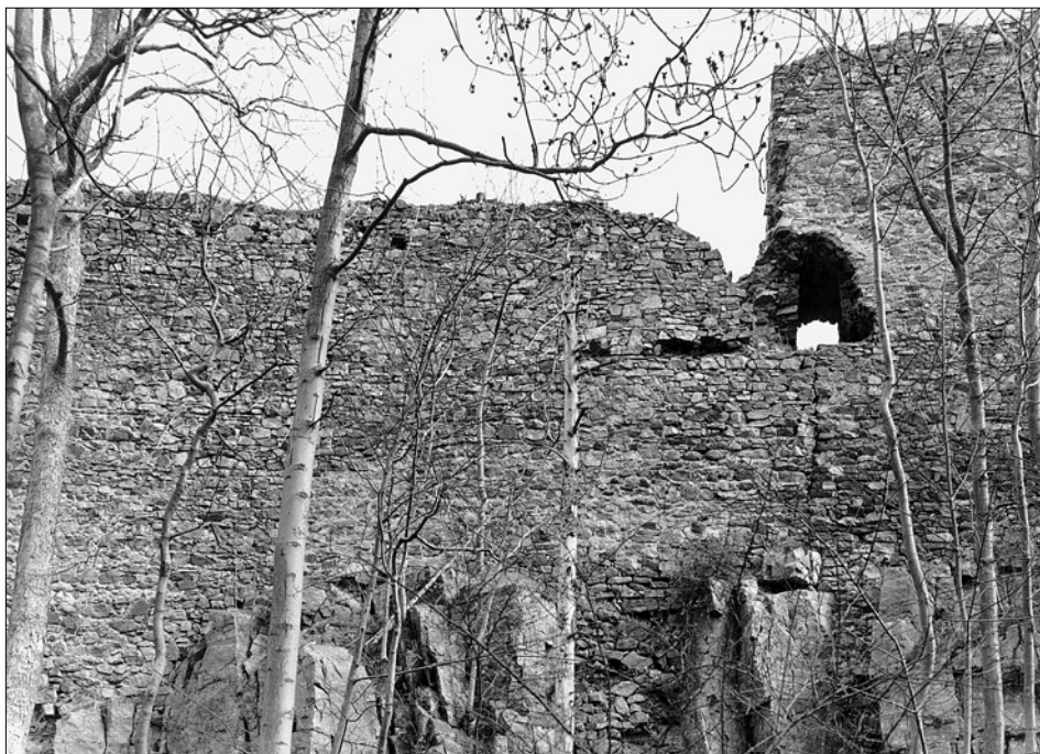
Obr. 3: Valdek, pohled z exteriéru hradu na západní hradební zeď a část paláce (vpravo), vzájemně oddělené svislou spárou v rozsahu přízemí. Otvor nad spárou patří vyústění chodbičky v síle nádvorní zdi (foto autor, 1999).
