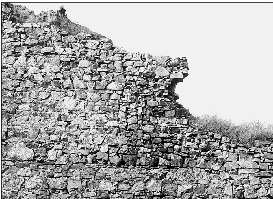
Obr. 20: Valdek, detail východního průčelí paláce (srov. obr. 4) v místě vyústění chodbičky v síle nádvoří zdi. Někdejší otvor je zřetelně nahrazen druhotně provedeným lícem zdiva (foto autor, 2000).
