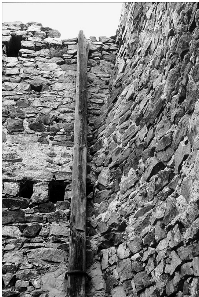
Obr. 10: Valdek, detail horní části jihozápadního rohu interiéru paláce. Vpravo nad kapsami stropních trámů 1. patra je vidět oblé navázání paty střešního štítu na jižní zeď (foto autor, 2000).
