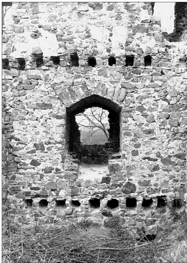
Obr. 5: Valdek, detail vnitřní strany jižní zdi paláce. Dole část záklenku okénka zasypaného přízemí, následují kapsy stropních trámů přízemí, střední okno 1. patra a kapsy stropních trámů stejného podlaží (foto H. Heckelová, 1999).
