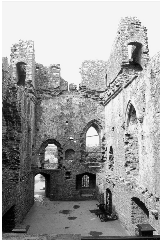
Obr. 22: Pembroke, hrad ve Walesu. Interiér paláce (srov. obr. 24) se stopami nízké střechy, konstrukčně přímo spojené s nárožními věžicemi a mezi- lehlým úsekem předprsně ochozu (foto autor, 2000).
