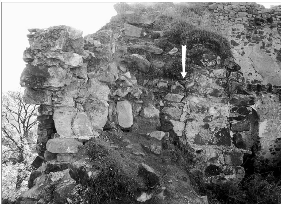
Obr. 19: Valdek, detail východního ukončení chodbičky v síle nádvoří zdi v pohledu od severu (kolmý pohled k obr. 18). Svislá spára (označena šipkou) je nárožím chodbičky v síle nádvoří zdi přicházející zprava a komunikace nejasného smyslu v síle východní zdi paláce. Do líce zadržky této komunikace byl přiložen záklonek směřující k vyústění na východním průčelí paláce (foto autor, 2000).
