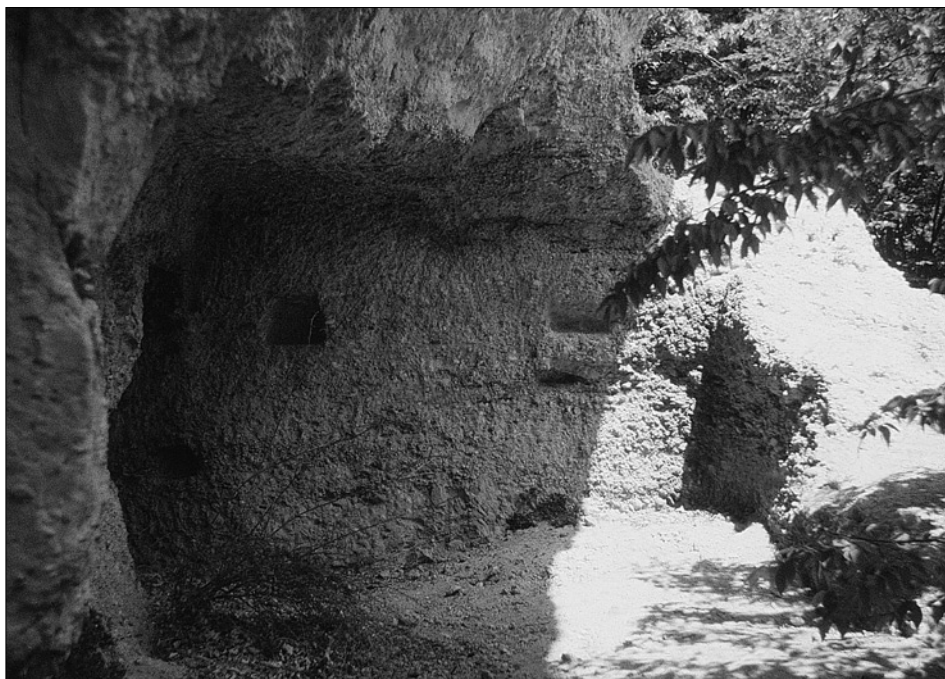
Obr. 6: Rottenstein (Rakousko), vytesaný základ palácové budovy jeskynního hradu ve výstupku skalní stěny (foto autor, 1993).
