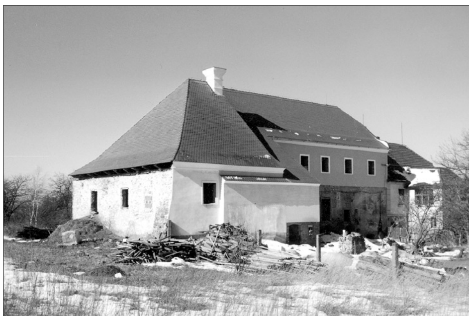
Obr. 4: Svinná (okr. Rokycany), celkový pohled na objekt od jihovýchodu, v popředí stěna s vystupujícím blokem nejstarší části stavby (foto T. Karel, 1999).
