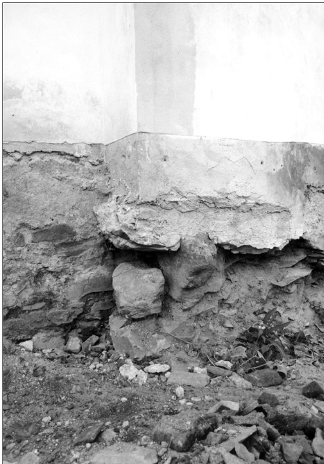
Obr. 7: Svinná (okr. Rokycany), detailní pohled na spodní část stěny s vystupujícím blokem nejstarší části stavby. Odhalené pískovcové kvádry lemuji vpadlinu pro padací most a odrazník vjezdu po odstranění novodobých sutin (foto T. Karel, 1999).
