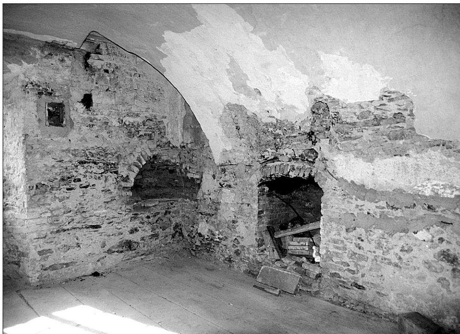
Obr. 8: Svinná (okr. Rokycany), detailní pohled na severozápadní kout místnosti bývalé kuchyně v západním křídle, patrný nízký pískový a příkladací otvor do sousední místnosti, u špalety okna kapsa pro osazení trámu dymníku (foto T. Karel 1999).
