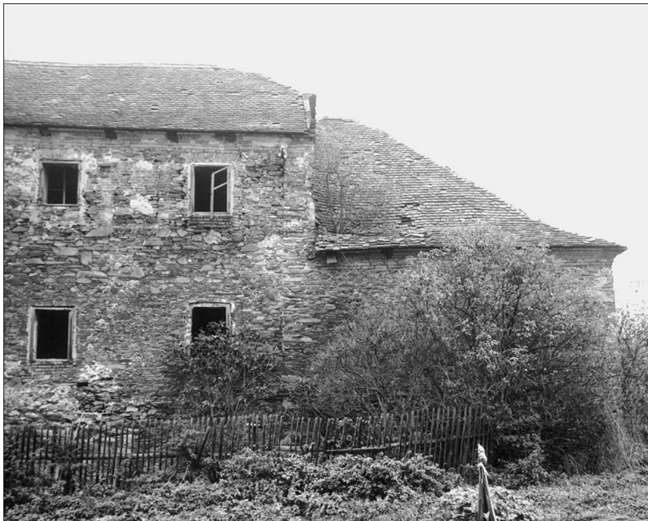
Obr. 5: Svinná (okr. Rokycany), pohled na objekt od západu s patrnou stavební spárou mezi jižním a západním křídlem s vysunutými šmorcný (foto archiv PÚ v Plzni, R. Kodera 1997).
