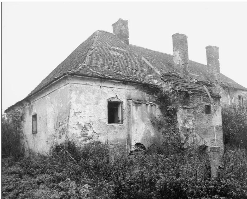
Obr. 6: Svirná (okr. Rokycany), pohled na objekt od jihovýchodu, v popředí stěna s vystupujícím blokem nejstarší části stavby (foto archiv PÚ v Plzni, R. Koderá 1997).
