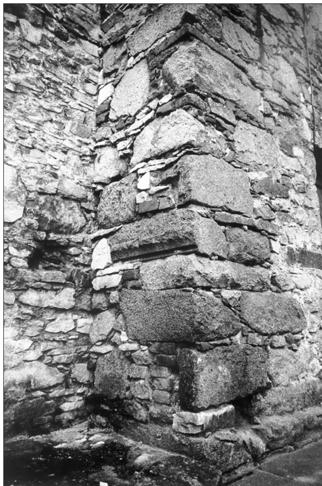
Obr. 12: Volyně, nároží přístavby bývalých děkanských stájí při dvorním průčelí tvrze s druhotně použitými opracovanými kamennými články.
