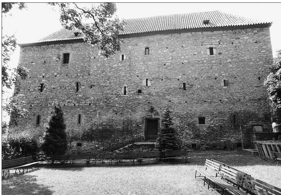
Obr. 6: Volyně, severní průčelí tvrze do nádvoří (stav r. 1999).
