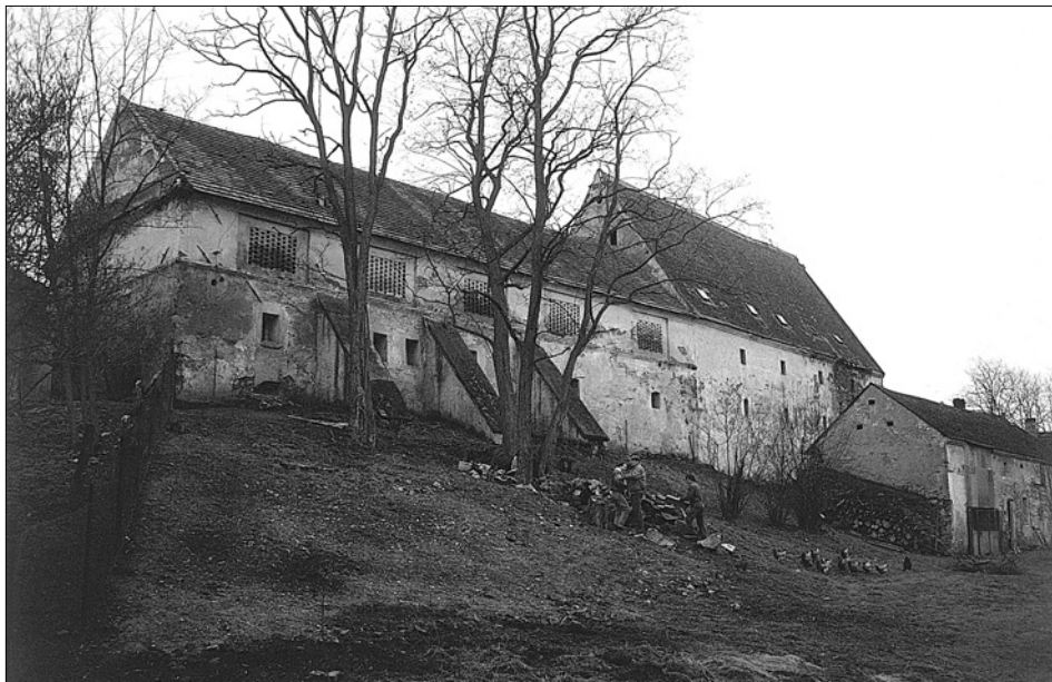
Obr. 3: Plešnice (okr. Plzeň - sever). Pohled na sýpku s přilehlým objektem, před nímž byl mezi stromy objeven vstup do sklepa (foto P. Mikota, 2000).
