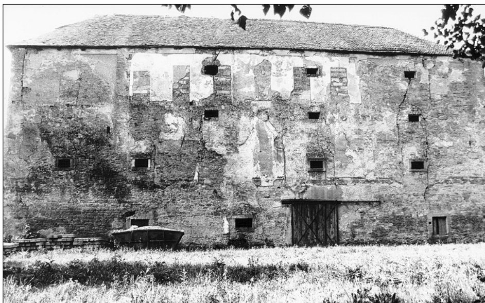
Obr. 2: Dohalice, pohled na severní průčelí sýpky (foto L. Svoboda, 1994).
