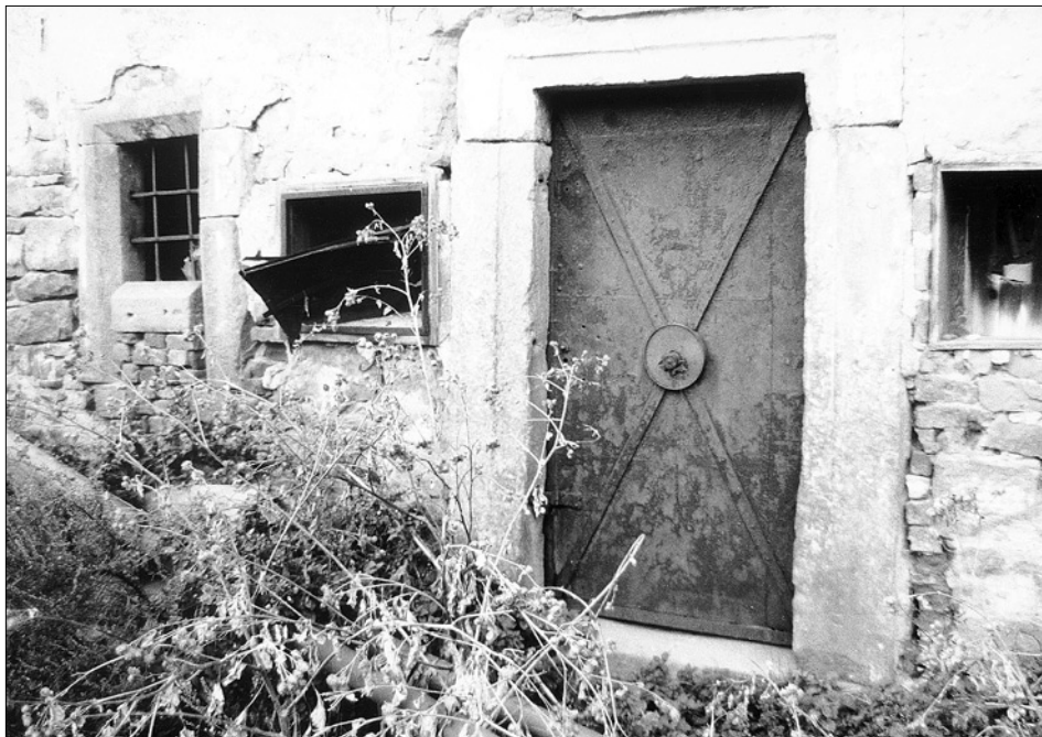
Obr. 8: Dohalice, pohled na dvojici otvorů v přízemí na východním průčelí sýpky (foto L. Svoboda, 1992).
