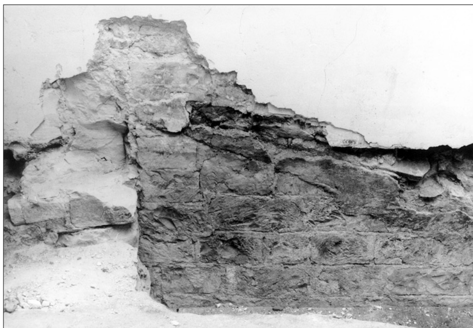
Obr. 2: Praha 1 - Staré Město, čp. 460/I. Západní stěna románské vstupní šíje s náběhem odstraněné šikmé klenby. Pohled od východu (foto K. Fírk).
