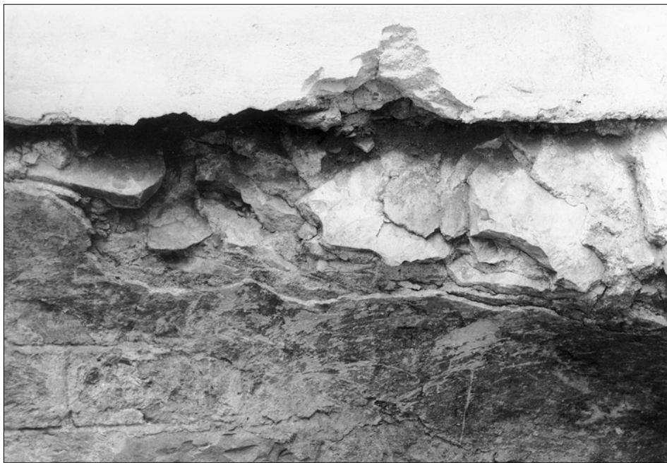
Obr. 4: Praha 1 - Staré Město, čp. 460/I. Detail přechodu kvádřikové stěny do valené klenby šíje s originálními maltovými vrstvami. Pohled od jihovýchodu (foto K. Fink).
