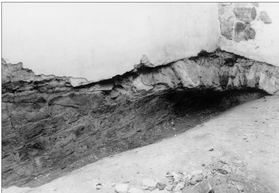
Obr. 3: Praha 1 - Staré Město, čp. 460/I. Severozápadní partie románské vstupní šíje se zbytkem dochované klenby. V popředí rub klenby gotického sklepa, při jehož výstavbě byla románská šíje rozebrána. Pohled od jihovýchodu (foto K. Fink).
