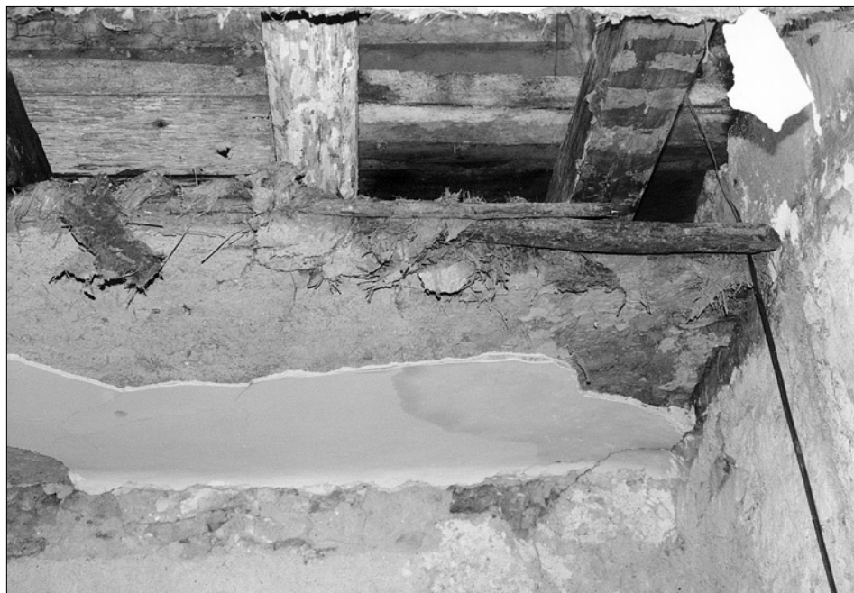
Obr. 7: Plzeň, čp. 126. Složení stropu v místnosti 202 v 1. patře (foto J. Anderle, 1999).
