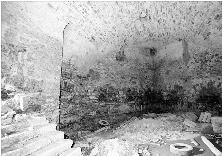
Obr. 6: Nové Město nad Metují, interiér přízemí bašty - pohled k severu. Vlevo fragment vylomené střílny, u nároží a ve vrcholu klenby větráky (foto PŮ Pardubice, V. Maryška).
