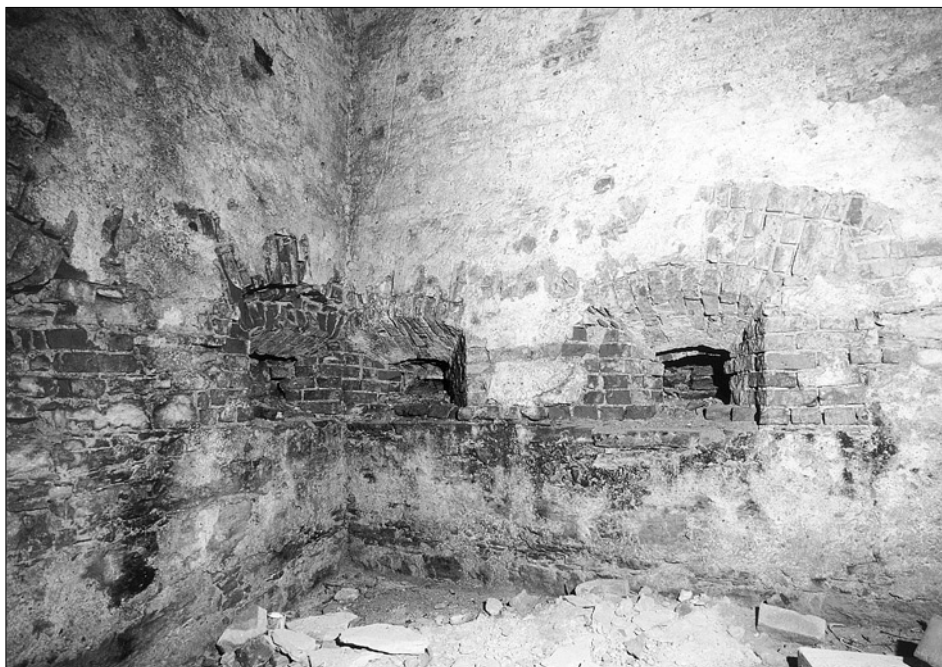
Obr. 8: Nové Město nad Metují, střilna v hrotu přízemí bašty (foto PÚ Pardubice, V. Maryška).
