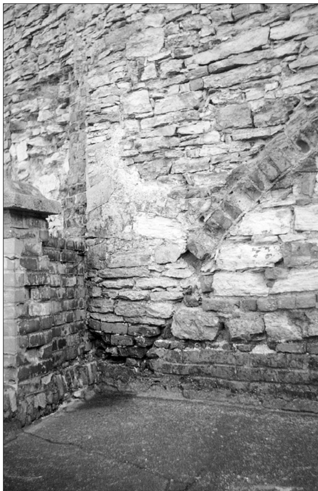
Obr. 15: Nové Město nad Metují, západní průčelí bašty. Detail napojení kleneb na zdivo bašty (foto J. Slavík).
