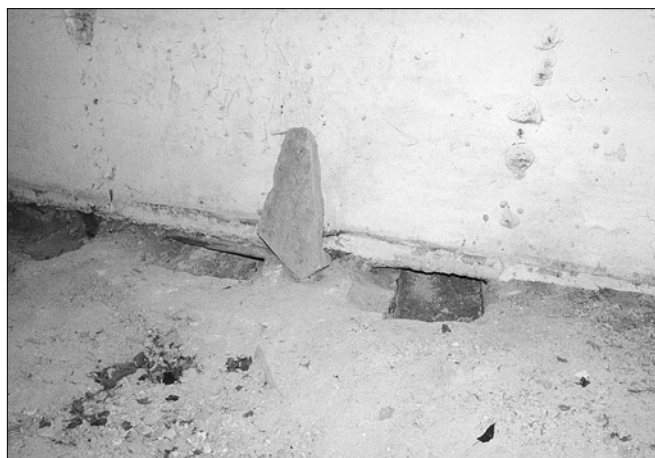
Obr. 18: Nové Město nad Metují, bašta Špýchar, větráky při východní stěně sálu v 1. patře (foto J. Slavík).
