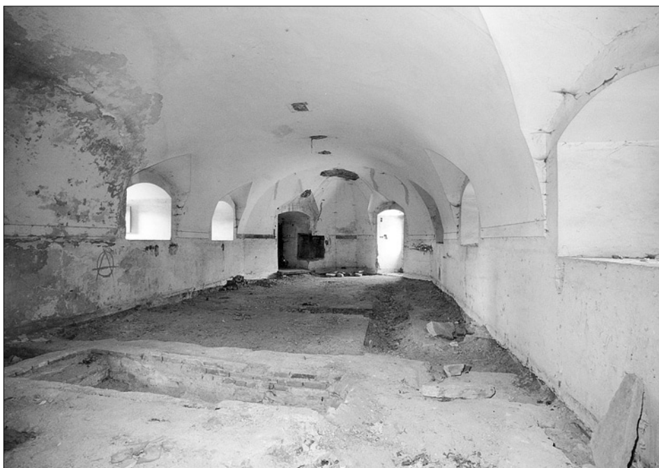
Obr. 13: Nové Město nad Metují, bašta Špýchar, průhled sálem 1. patra k severu. V popředí schodiště z mezipatra (foto PÚ Pardubice, V. Maryška).
