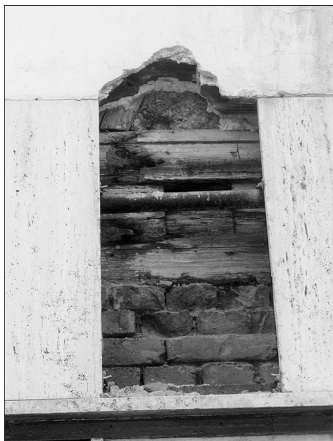
Obr. 8: Karlovy Vary, dům „Maltézský kříž“, dnes „Heda“ č. 50 na Staré Louce - sonda mezi přízemím a 1. patrem uličního průčelí s odkrytou profilovanou římsou.
