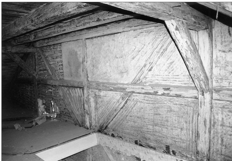
Obr. 11: Karlovy Vary, dům „Sedm planet“, výplet hrázděné konstrukce a dekorativní vrypy v podkrovní.
