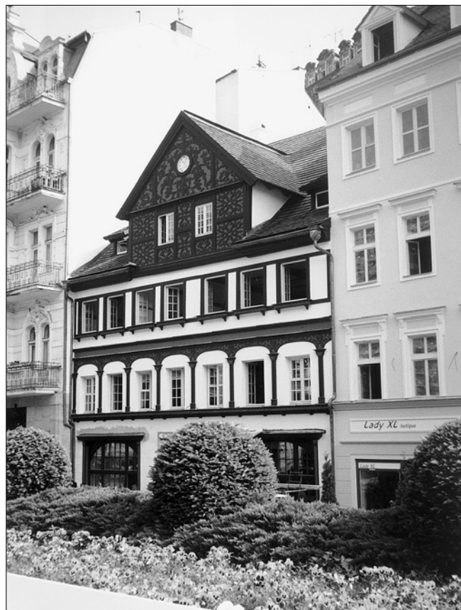
Obr. 17: Karlovy Vary, dům „U zlatého vola“ - „Petr“ - uliční průčelí po rekonstrukci (všechny fotografie autor).
