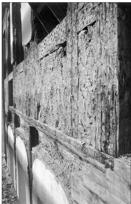
Obr. 15: Karlovy Vary, dům „U zlatého vola“ - „Petr“ - detail předsazené hrázděné konstrukce uličního průčelí (foto a zaměření L. Zeman).
