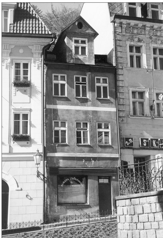
Obr. 8: Karlovy Vary, dům „Maltézský kříž“, dnes „Heda“ č. 50 na Staré Louce - sonda mezi přízemím a 1. patrem uličního průčelí s odkrytou profilovanou římsou.
