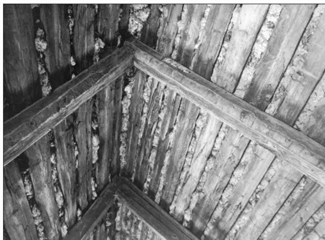
Obr. 10: Horní Jadruž (okr. Tachov), sýpka usedlosti č. 13, podkroví, pohled na vnitřní krov krytý z vnější strany povalem s hliněným lepencem.
