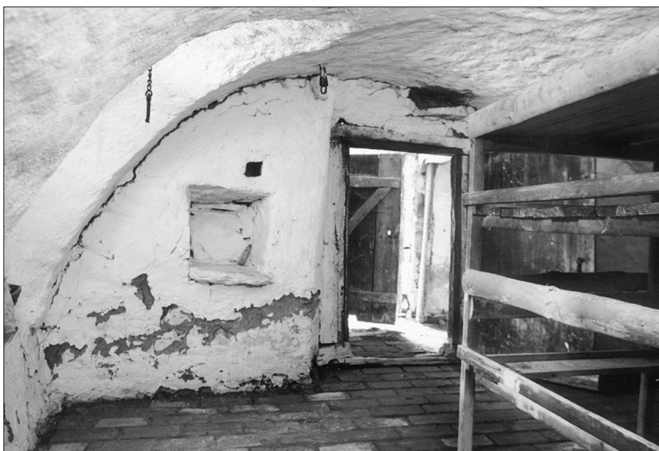
Obr. 8: Horní Jadruž (okr. Tachov), sýpka usedlosti č. 13, přízemí, pohled ze „sklepa“ západním směrem k sekundárně vložené přčce s průhledem ke vstupu do objektu.
