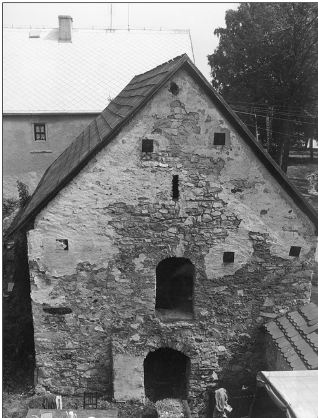
Obr. 7: Horní Jadruž (okr. Tachov), západní průčelí sýpky usedlosti č. 13.
