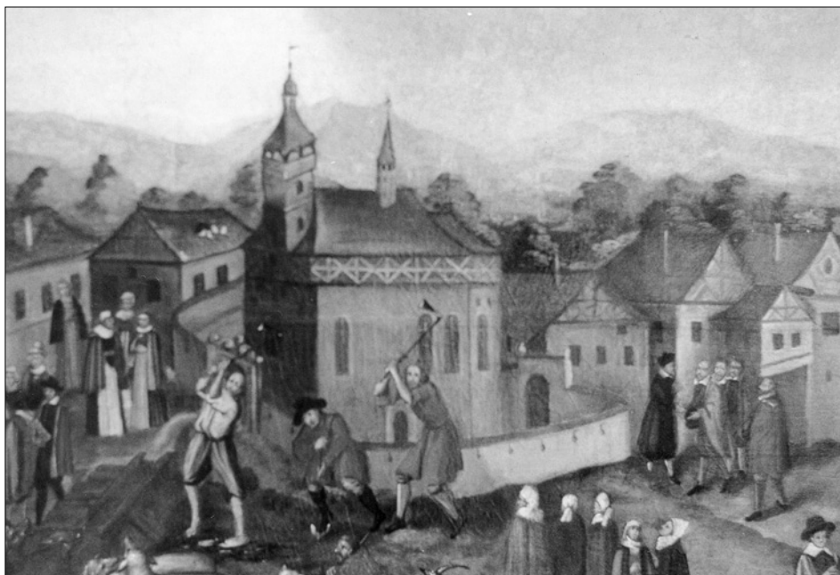
Obr. 2: Hostouň, kostel sv. Jakuba na druhém vyobrazení z 1. pol. 17. stol. Dobře patrné je hrázdné polopatro kostela. Na tomto vyobrazení je polopatro od zdiva poměrně výrazně odsazeno a budí spíše dojem obranného podsebití (depozitář zámku v Horšovském Týně).
