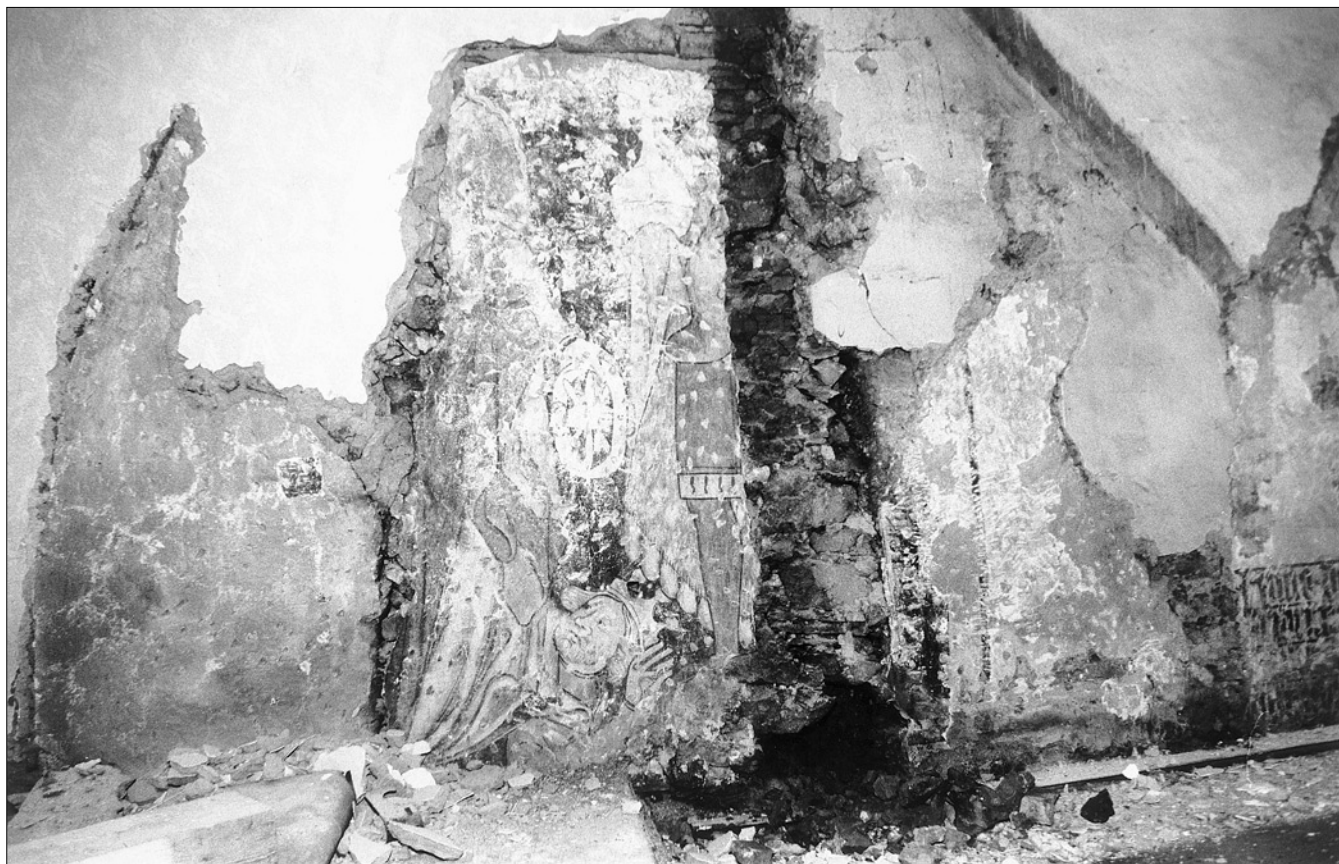
Obr. 9: Rožmberk nad Vltavou, dům čp. 6. Detail střední části jihovýchodní stěny domu. Uprostřed snímku jizva po vybourané přičce (asi vestavěné v 19. stol.). Vlevo výběh čelního oblouku středního pole gotické klenby. Po stranách jizvy po přičce zachované části gotické nástěnné malby se světeckými postavami. Při pravém okraji snímku odsekaný výběh gotické klenby a vpravo od něj omítka s gotickými nápisy (konstrukci pozdějšího stropu jsou zakryty zbytky obrazů klečících donátorů se vztahem k nápisu) (foto J. Sommer, 1997).
