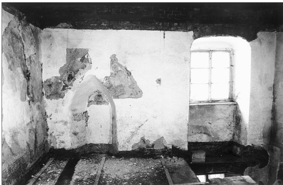
Obr. 12: Rožmberk nad Vltavou, dům čp. 6. Jihozápadní stěna domu v úrovni prvního patra. V levé části snímku vnitřní špaleta gotického okna. Hrana špalety je rámována dodatečně malovaným iluzivním kvádrováním. Vpravo od okna je částečně odhalena stopa odsekaného čelního oblouku gotické klenby. Zcela vlevo je viditelný úsek jihovýchodní stěny domu, na jejíž omítce jsou těsně nad podlahou viditelné části gotického malovaného nápisu. V pravé části snímku je okno z počátku 19. století (foto J. Sommer, 1997).
