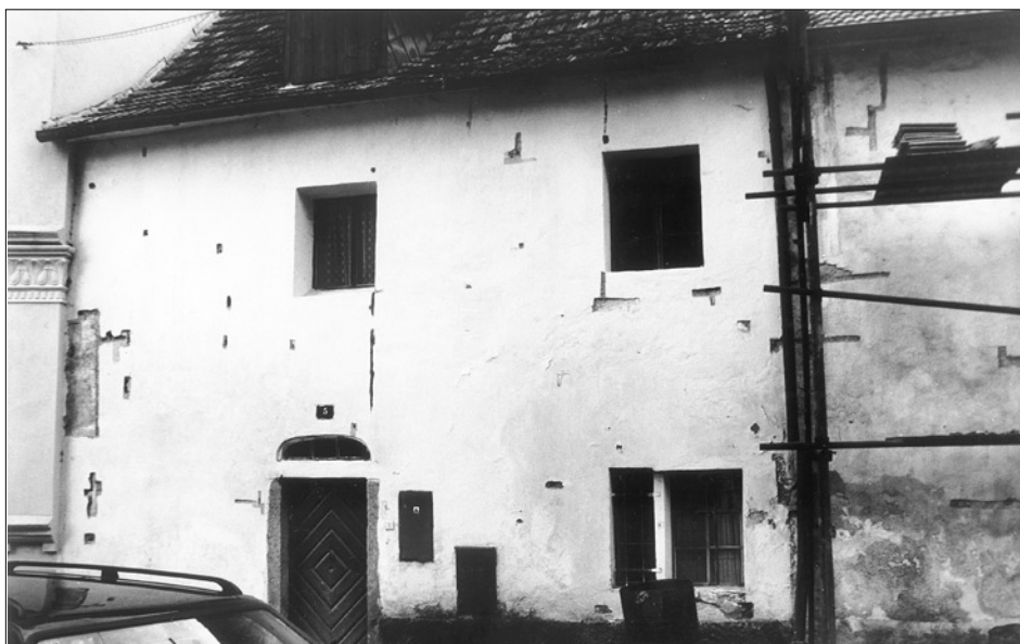
Obr. 3: Rožmberk nad Vltavou, dům čp. 5. Jihozápadní průčelí. Vlevo restaurátorská sonda s odhaleným malovaným kvádrováním západního nároží gotické kaple. Nad pravou stranou vstupního portálu visí sonda sledující východní hranu druhotně zřízeného barokního okna, zrušeného při přestavbě na obytný dům (foto J. Sommer, 1977).
