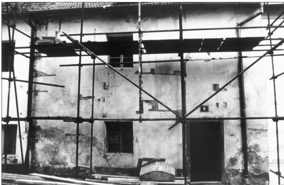
Obr. 4: Rožmberk nad Vltavou, dům čp. 6, jihozápadní průčelí. Nad vstupním portálem je restaurátorskými sondami částečně odhalena vnější stěna špalety gotického okna. Vlevo mezi oknem přízemí a prvního patra viditelné hrany druhotně zřízeného, později zrušeného barokního okna (foto J. Sommer, 1977).
