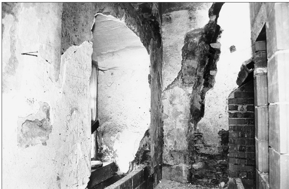
Obr. 11: Rožmberk nad Vltavou, dům čp. 6. Západní kout přízemí domu. Vlevo okno v jihozápadní stěně, které bylo zřízeno na počátku 19. století. V pozadí snímku náběh cihelné konstrukce oblouku, který byl přiložen nejspíše kolem roku 1379 k boku klenebního žebra, jehož výběh byl umístěn na jihozápadní stěně (foto J. Sommer, 1997).
