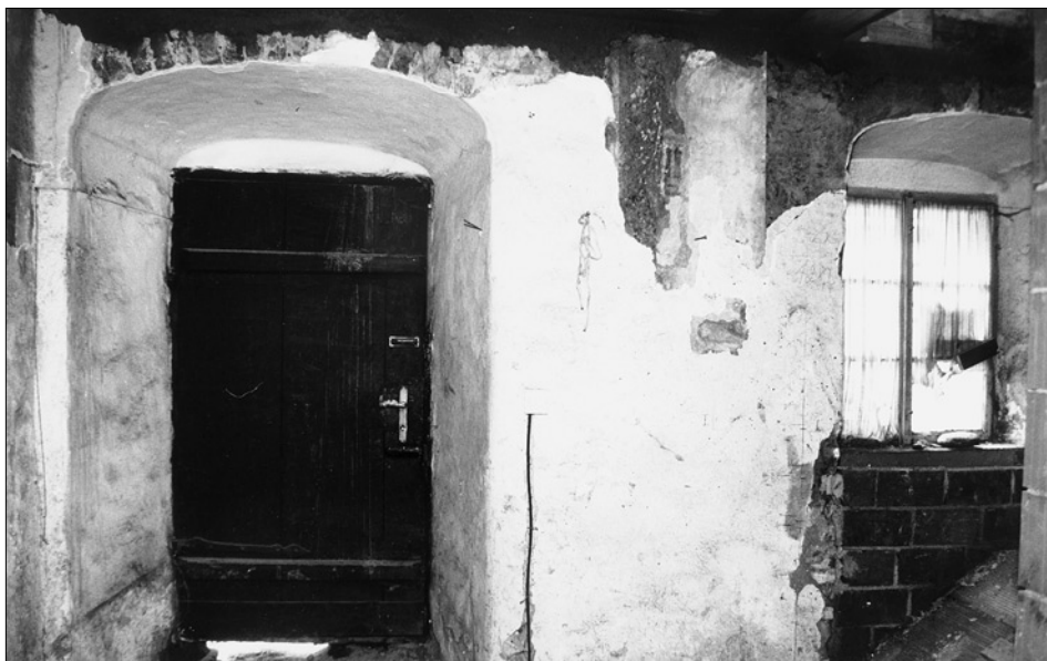
Obr. 10: Rožmberk nad Vltavou, dům čp. 6. Jihozápadní stěna přízemí domu. Portálek a okno pocházející z počátku 19. století. Vlevo od okenního výklenku patrná hrana vnitřní špalety dodatečně vybouraného a později opět zrušeného barokního okna. Uprostřed snímku pozůstatky odsekaného výběhu gotické klenby, na nějž vpravo navazuje drobný fragment gotického nápisu (foto Jan Sommer, 1997).
