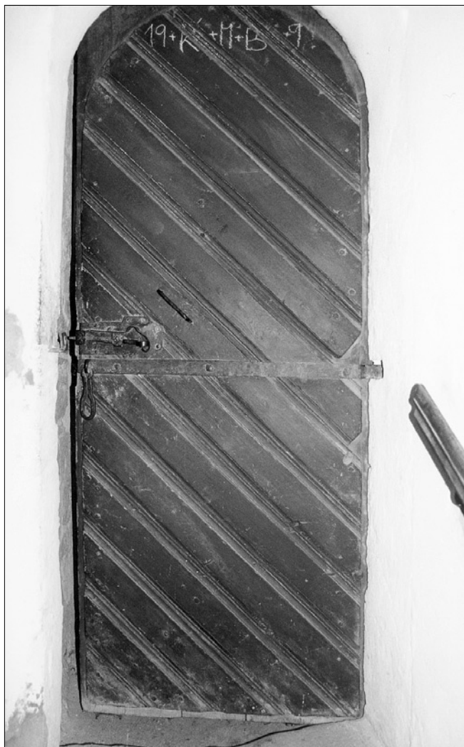
Obr. 3: Kostomlaty pod Milešovkou (okr. Teplice), kostel sv. Vavřince, dveře z presbytáře k přístupovému schodišti do zvonicového patra věže a krovu (foto autor, 2000).
