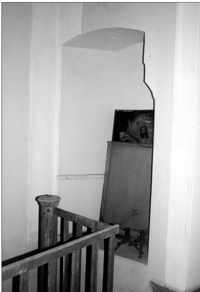
Obr. 5: Kostomlaty pod Milešovkou (okr. Teplice), kostel sv. Vavřince, pozůstatek původního přístupu ze zámku na kůr krytým mostem (foto autor, 2000).
