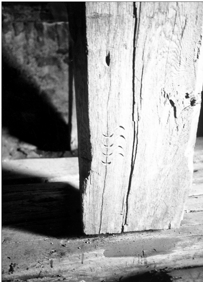
Obr. 5: Kostelec nad Vltavou, kostel Narození P. Marie, tesařské značky na zvonové stolici.
