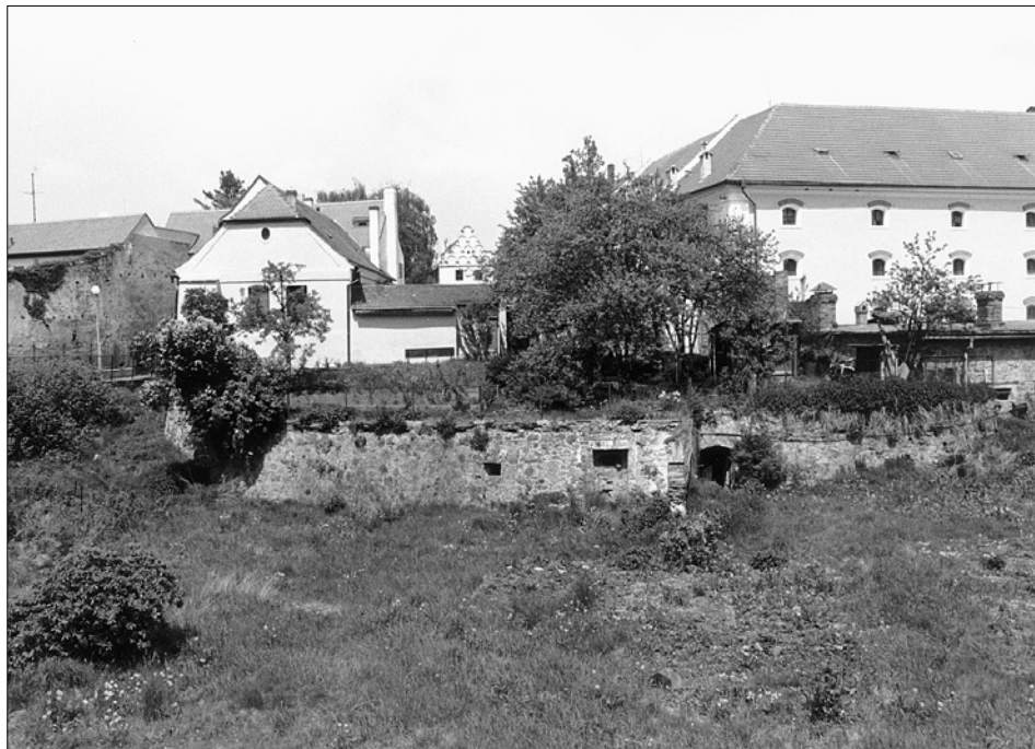
Obr. 5: Třeboň, část opevnění východně od Svinenské brány, dnešní stav [foto V. Razím].
