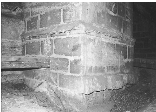
Obr. 11: Chrudim, kostel Nanebevzetí P. Marie. Podstřeší severního přístavku kněžiště, pohled na schodišťovou věžici od severovýchodu (srov. obr. 10). Na východní stěně věžice druhotný zásek pro ramenát křížové klenby a její otisk, na severní stěně věžice (vpravo) dole dvě řady nevyužitých šmorců.
