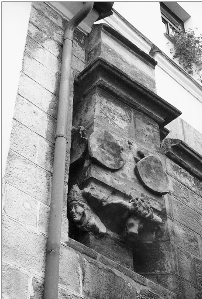
Obr. 31: Chrudim, východní průčelí domu čp. 57 (tzv. stará škola). Detail jižního opěráku s původní heraldickou a figurální výzdobou. Opěrák obklopuje předstupující novodobé zdivo z kvádrů, jímž byla dodatečně zesílena východní zeď domu.
