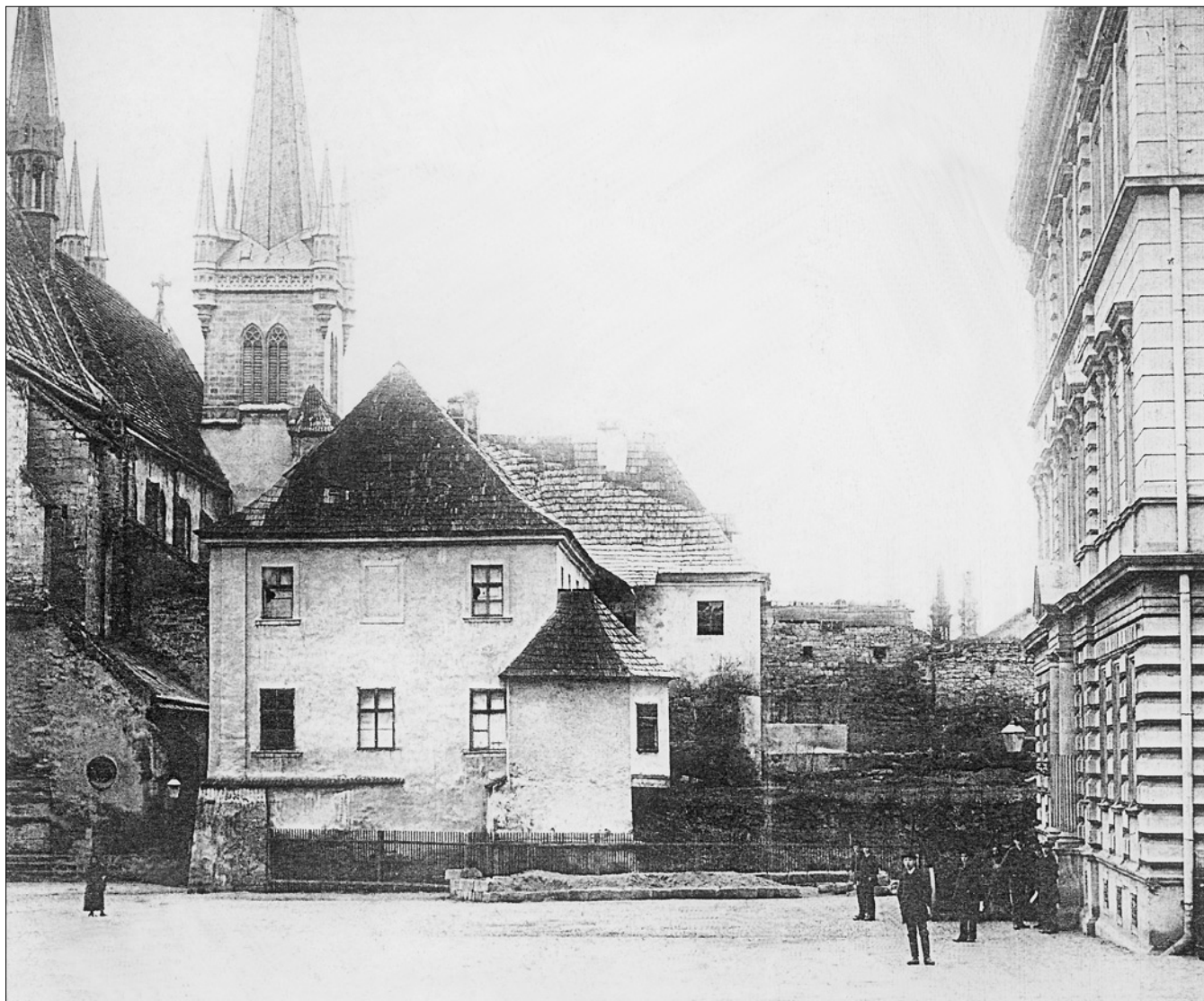
Obr. 28: Chrudim, snímek starého děkanství (čp. 56) v pohledu od východu. V dolní části průčelí šikmo probíhající část zdíva, která patrně nesouvisí se zdívem ve vyšších partiích, upravo nárožní rizalit. Vpravo od budovy val, na němž stojí hlavní hradba městského opevnění s jednou z věží (Okresní muzeum Chrudim, před rokem 1890).
