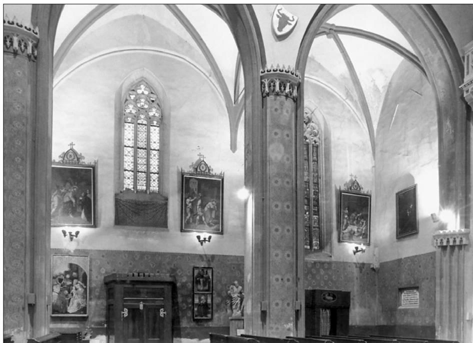
Obr. 20: Chrudim, kostel Nanebevzetí P. Marie. Pohled z interiéru severní lodě k jihu. V popředí piliře mezilodních arkád se zdobnými hlavicemi, rekonstruovanými či provedenými F. Schmoranzem. Vpravo při nároží věže svazková přípora původně plánovaných nižších arkád. V pozadí stěna jižní lodě s nápadně nepravidelnými oblouky přízedních žebíř, naznačujícími zamýšlenou nižší klenbu. V jihozápadním koutu lodě jedna z konzol této nerealizované klenby.
