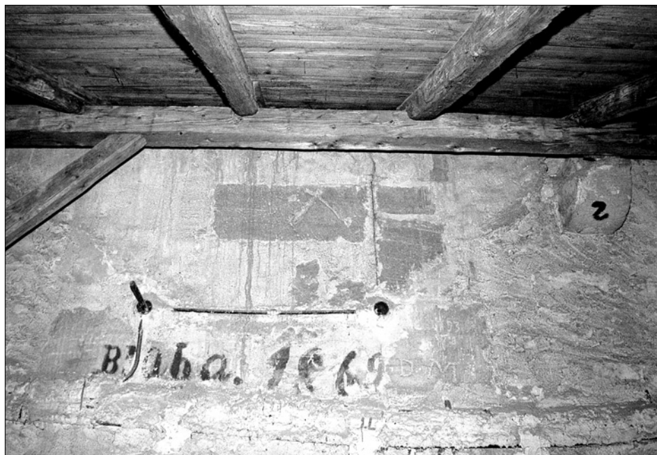
Obr. 25: Chrudim, kostel Nanebevzetí P. Marie. Detail podstřeší severní lodě. Pohled od severu na stěnu hlavní lodě, uprostřed jedno ze zazděných oken, vpravo konzola starší střechy. Od spodních částí zazdívků okna šikmo nahoru vybíhají otisky jedné ze starších střech.
