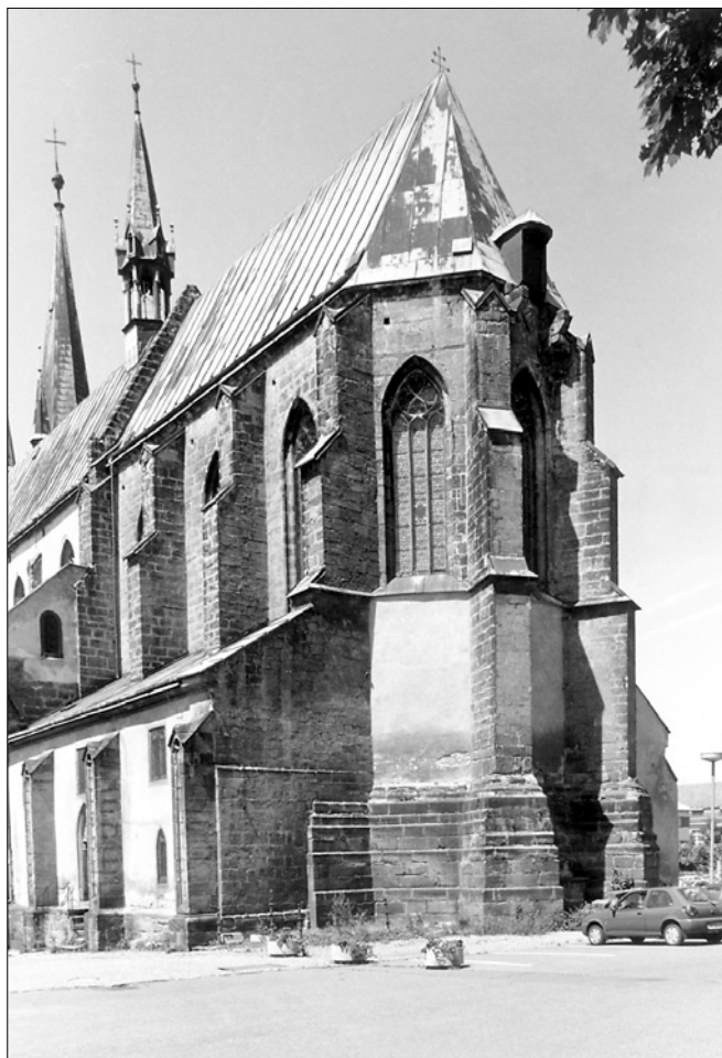
Obr. 5: Chrudim, kostel Nanebevzetí P. Marie. Presbytář v pohledu od jiho-východu. Dobře je patrna skladba východní zdi jižního přístavku presbytie a Schmoranzem mohutně zesílený sokl závěru.
