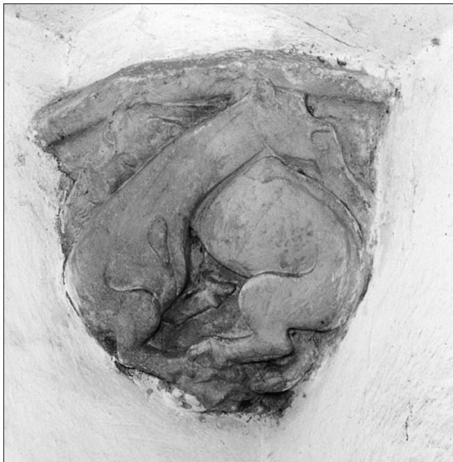
Obr. 21: Chrudim, kostel Nanebevzetí P. Marie. Jedna ze zoomorfních klenbových konzol interiéru jihozápadní věže.
