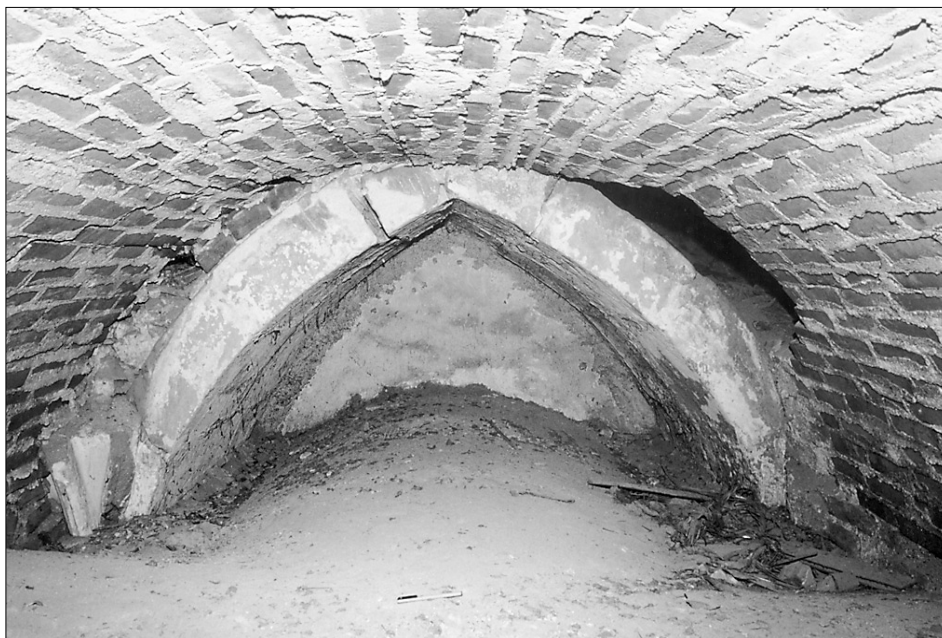
Obr. 12: Chrudim, kostel Nanebevzetí P. Marie. Gotická hrotitá klenba při severní straně schodiškové věžice presbyteria v pohledu od východu, z meziklenebního prostoru nad tzv. stříbrnou komorou. V popředí po stranách výběhy žeber zaniklé křížové klenby.
