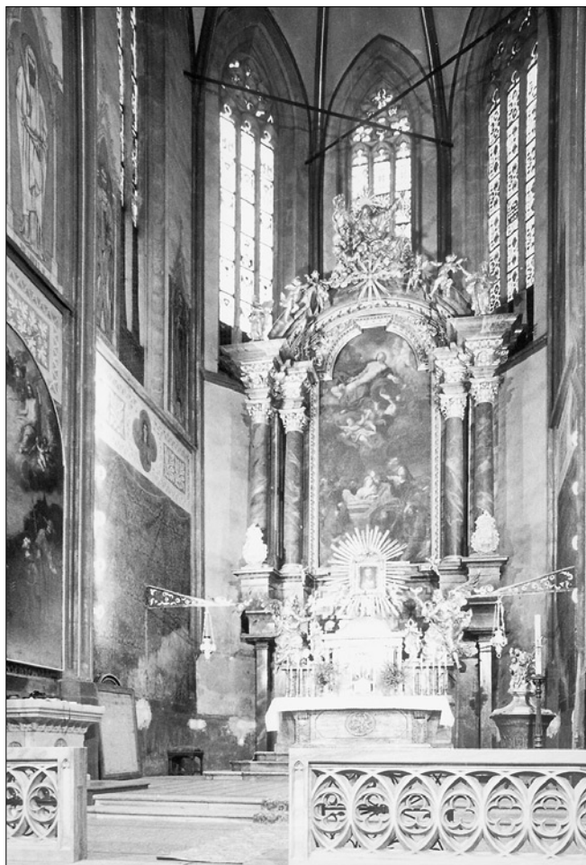
Obr. 6: Chrudim, kostel Nanebevzetí P. Marie. Pohled do závěru presbytáře se dvěma úrovněmi podokenních říms a zazdívkami spodních částí oken. Vlevo za oltářem částečně vyčnívá ostění vysoko položeného sanktuáře.
