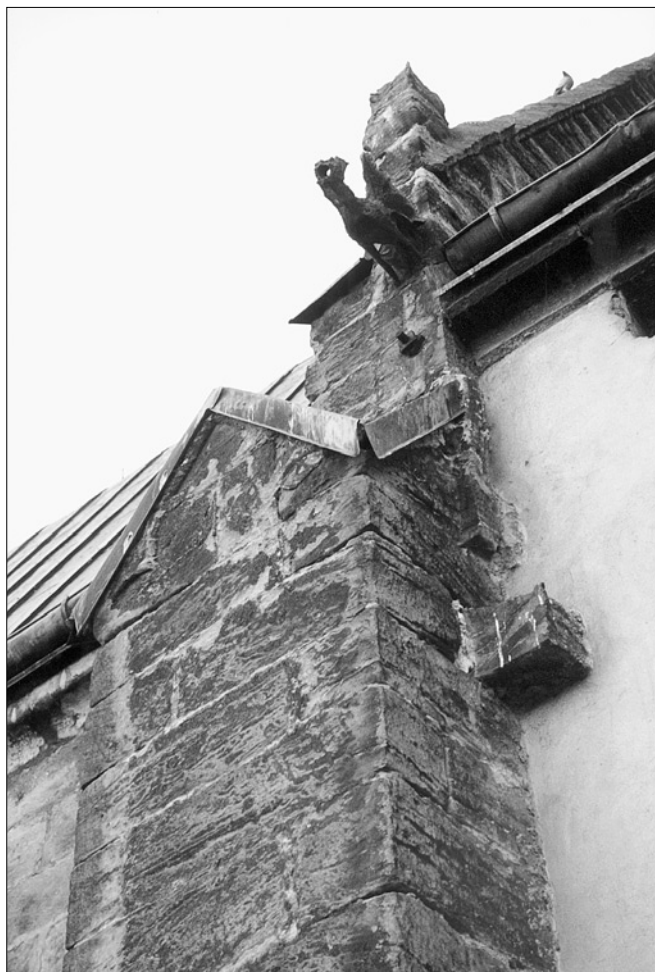
Obr. 23: Chrudim, kostel Nanebevzetí P. Marie. Detail horní části západního opěráku na severní straně kněžiště. Vpravo dva šmorce připravené pro navázání zdi hlavní lodě, výše pata střešního štítu s pilířkem zaniklé fiály a chrličem.
