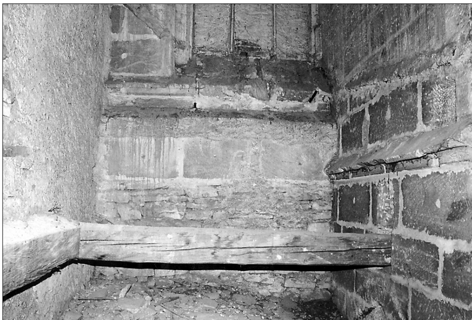
Obr. 10: Chrudim, kostel Nanebevzetí P. Marie. Podstřeší severního přístavku kněžiště, pohled od severu k severnímu oknu pětibokého závěru. Pod bankálovou římsou okna předstupuje zdivo, na spáru vložené mezi schodišťovou věžici (vpravo) a opěrák z lomového zdiva (vlevo), interpretovaný jako relikt hlavní hradby městského opevnění. Vlevo od okna a na schodišťové věžici otisk starší střechy, vpravo ostění s redukovanou profilací.
