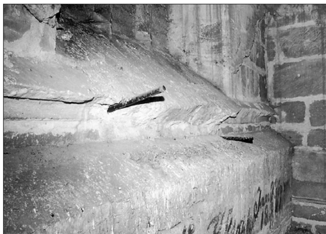
Obr. 13: Chrudim, kostel Nanebevzetí P. Marie. Podstřeší severního přístavku kněžiště, detail bankálové římsy středního pole (nad dochovanou žebrovou klenbou). Část římsy pod oknem nebyla profilována. Pod římsou druhotná příložka. Pohled od východu.
