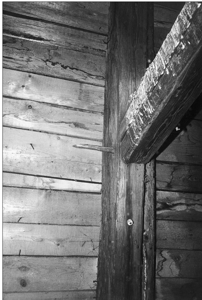
Obr. 5: Chrudim, kostel Nanebevzetí P. Marie, detail vyčnívajícího dřevěného hřebu na spoji hambalku a severní krokve v 15. vazbě.
