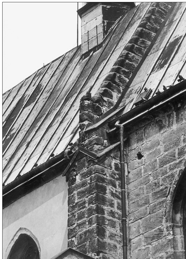
Obr. 13: Chrudim, kostel Nanebevzetí P. Marie, detail dělicí zdi s náběhem pro námetek.
