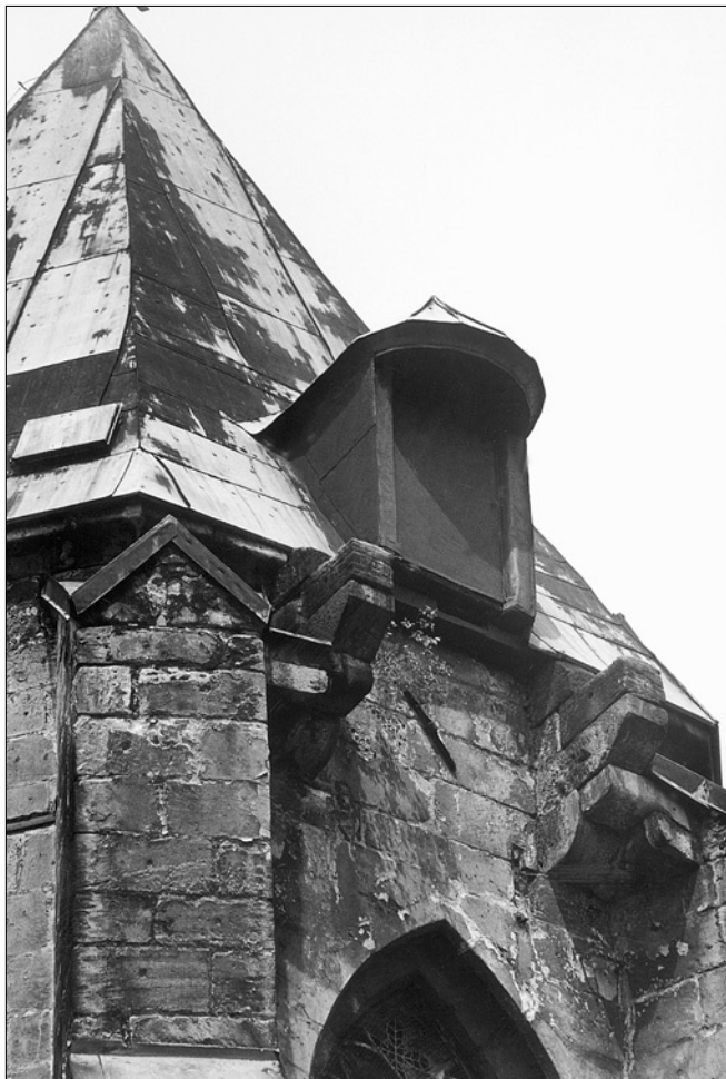
Obr. 4: Chrudim, kostel Nanebevzetí P. Marie, detailní pohled na vikýř v ose východního konce střechy a mohutné krakorcové konzoly pod ním (všechny snímky Jiří Bláha, 2001)
