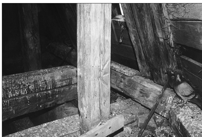
Obr. 8: Chrudim, kostel Nanebevzetí P. Marie, detail číslování severní patní vzpěry v 16. vazbě.
