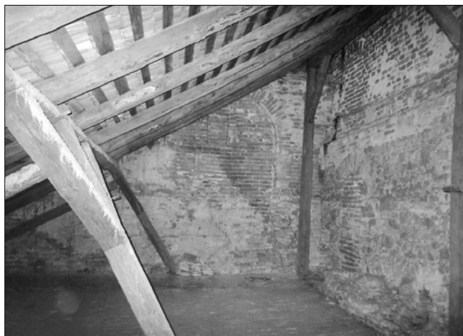
Obr. 18: Hrad Malenovice, západní příčná zeď severního křídla půdních prostor s patrným otiskem zaniklé konstrukce krovu.
