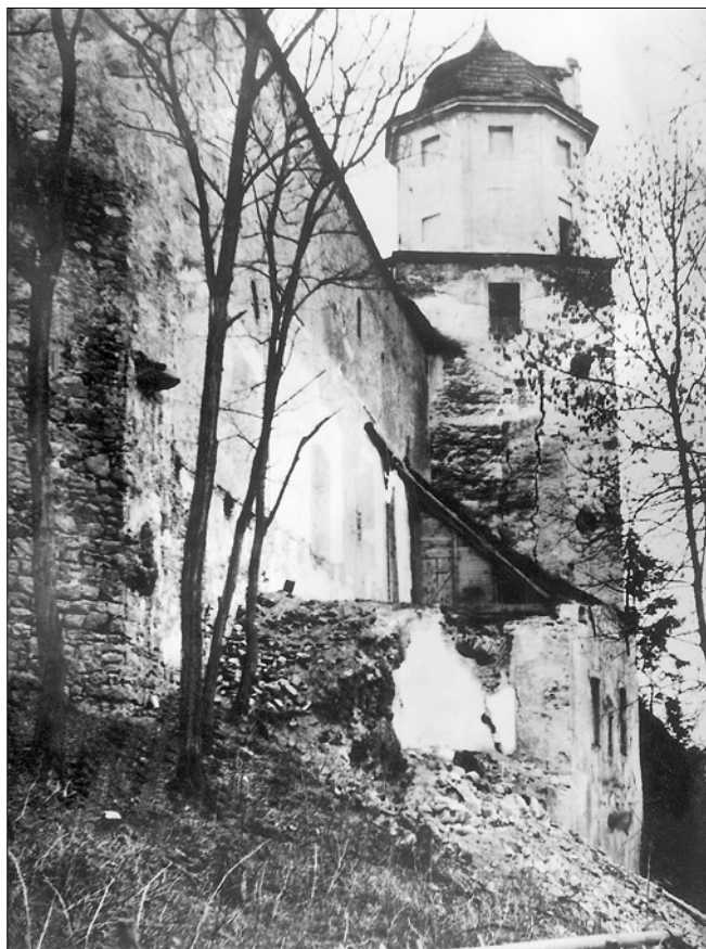
Obr. 19: Hrad Malenovice, demolice traktu vestavěného do gotického parkánu. V obvodové zdi jádra jsou patrné stopy zazděného dveřního otvoru v bývalém patře a stopy po stropních trámech. Ve stojícím torze přízemí patrná klenba (snímek z 50. let 20. století, fotoarchív PÚ v Brně).
