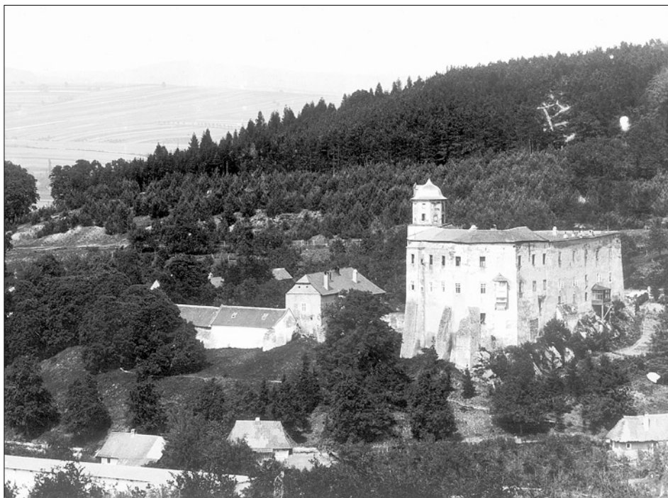
Obr. 1: Hrad Malenovice (okr. Zlín), pohled na areál hradu od jihozápadu; vlevo předhradí s dnes již neexistujícími hospodářskými budovami (dvojice nižších objektů zcela vlevo), upravo hradní jádro. Pozdně gotická část se vstupní věží a traktem s reprezentačními prostory (křídlo s opěrnými pilíři a arkýřem) navazuje na starší část; z ní je na snímku viditelná část jižního průčelí (vpravo - původnímu jádru náleží část fasády s pěti okenními osami) (snímek z počátku 20. století, fotoarchív Muzea jihovýchodní Moravy ve Zlíně).
