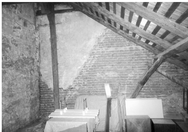
Obr. 11: Hrad Malenovice, pohled na příčnou cihelnou zeď jižního traktu - vlevo jižní úsek obvodové zdi; v příčné zdi je dobře patrný otisk starší konstrukce krovu; vlevo pultová stříška, pod ní otisk okapového žlabu, pak náběh sedlové střechy.
