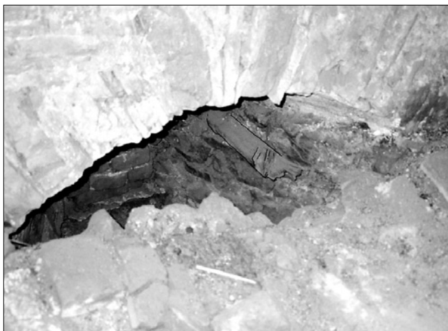
Obr. 7: Hrad Malenovice, severní úsek obvodové zdi - otvor střílny pod úrovní podlahy pudy; z pravé špalety vyčnívá část vetknuté tyče dřevěného lešení (viz obr. 5/3).
