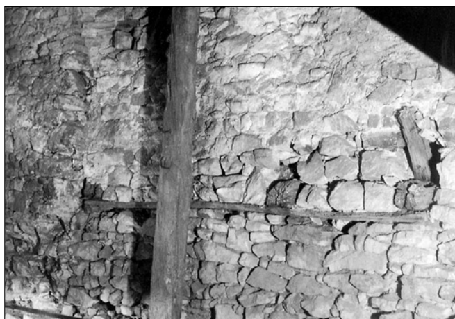
Obr. 10: Hrad Malenovice, východní úsek obvodové zdi - vlevo líč zdiva původní hradby ze 2. poloviny 14. století, ukončený svislou spárou (obr. 5/15), dále následuje hrubě líčované zdivo s pozůstatky dřevěných konstrukcí (podkladní fošna se zbytky 4 trámů; do pravého z nich je začepován fragment vzpěry).
