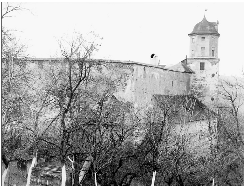
Obr. 20: Hrad Malenovice, pohled na hradní jádro od severovýchodu, vpravo vstupní věž, pod oknem její spodní, hranolové části je patrný otisk pultové střechy traktu, vestavěného do gotického parkánu. Budova byla později snížena (viz foto) a v 50. letech 20. století byl i tento zbytek zcela zbytečně zbořen (snímek z počátku 20. století, fotoarchív PÚ v Brně).
