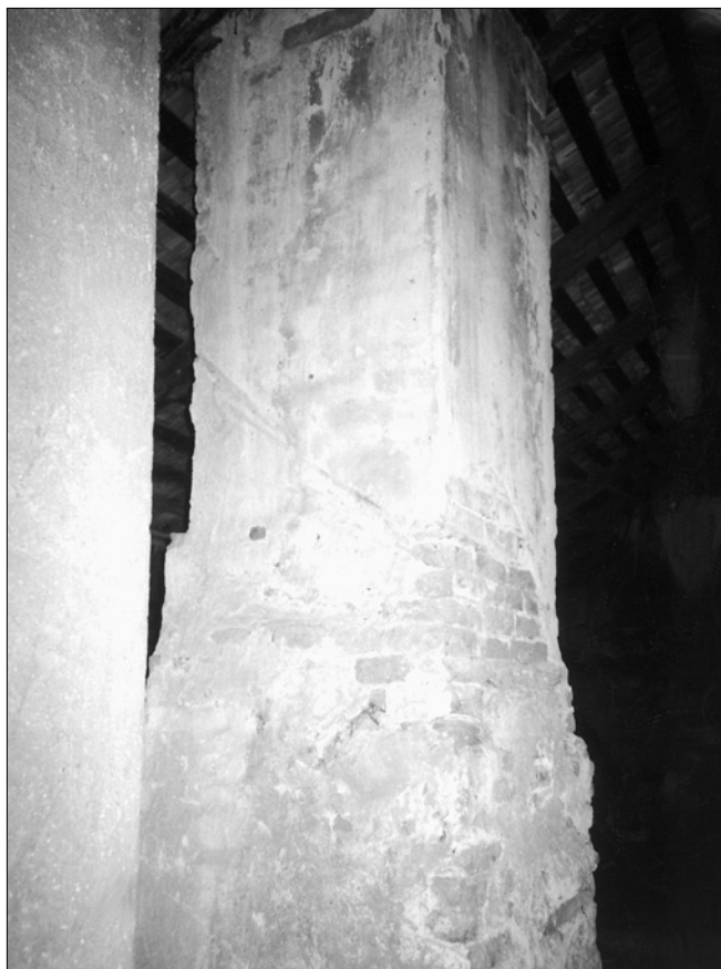
Obr. 17: Hrad Malenovice, volně stojící komín v severním křídle půdních prostor; v jeho omítce je patrný otisk zaniklé konstrukce krovu.
