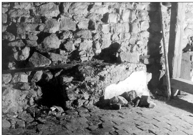
Obr. 9: Hrad Malenovice, východní úsek obvodové zdi - v horní části snímku hrubě líčované zdivo, nad podlahou půdy fragmenty zdiva s interiérovými omítkami a jizvou po nádvoří zdi gotického objektu (v popředí).
