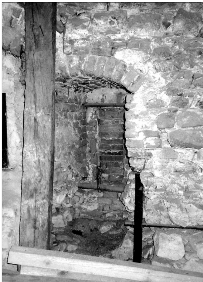
Obr. 8: Hrad Malenovice, východní úsek obvodové zdi - cihelné špalety a záklenek otvoru, druhotně vhloubeného do hradby ze 2. poloviny 14. století (dělová komora?).
