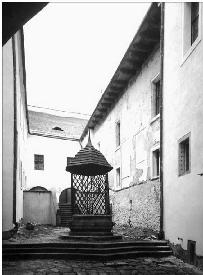
Obr. 2: Hrad Malenovice, pohled z hradního nádvoří na východní část hradního jádra. Mříž a střecha studny kryje hmotu gotické stavby v jihovýchodním nároží hradební zdi, vpravo na ni navazuje snad současná stavba s nově objevenou exteriérovou malbou. Pod schodištěm v popředí se předpokládá západní hradba původního jádra (není-li uvedeno jinak, snímky i kresby autor, 2000).
