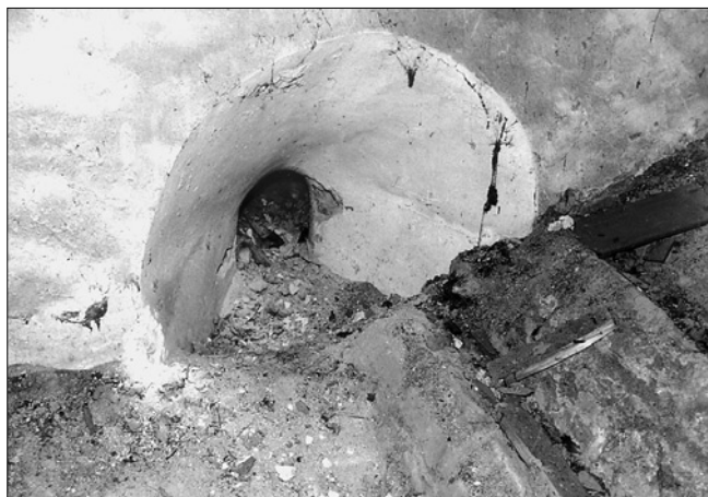
Obr. 17: Čížová, kostel sv. Jakuba Většího. Podkroví lodi. Pohled do spalety nejvýchodnějšího z trojice původních okének v severní stěně lodi.
