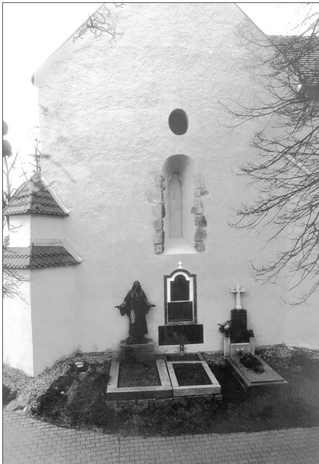
Obr. 5: Čížová, kostel sv. Jakuba Většího. Východní stěna presbyteria. Stav po opravě.
