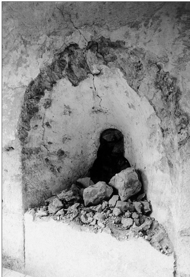
Obr. 6: Čížová, kostel sv. Jakuba Většího. Horní část vnější špalety východního okna presbyteria v době odstraňování zadržky.
