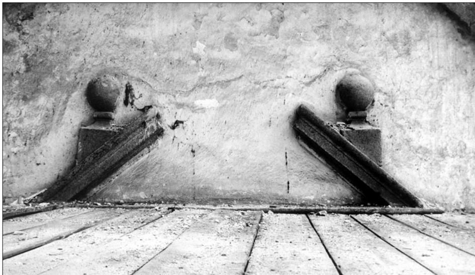
Obr. 22: Čížová, kostel sv. Jakuba Většího. Jižní stěna lodi. Detail nástavce barokního vstupního portálu, krátkodobě přístupný během opravy střešní krytiny předsíně. (Všechny snímky a kresby J. Sommer, 1997 - 2001)
