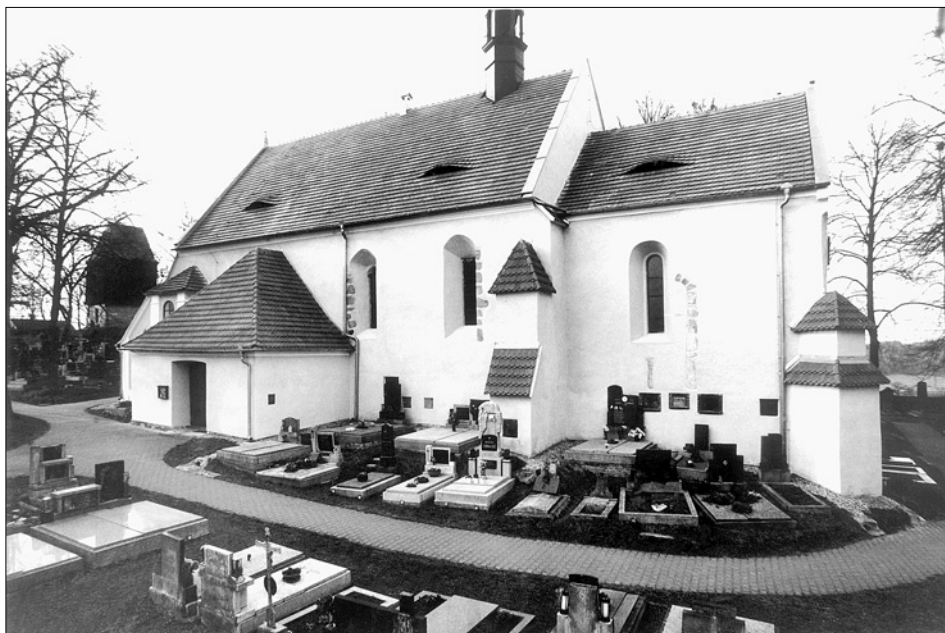
Obr. 4: Čížová, kostel sv. Jakuba Většího. Celkový pohled na kostel od jihu. Stav po opravě.
