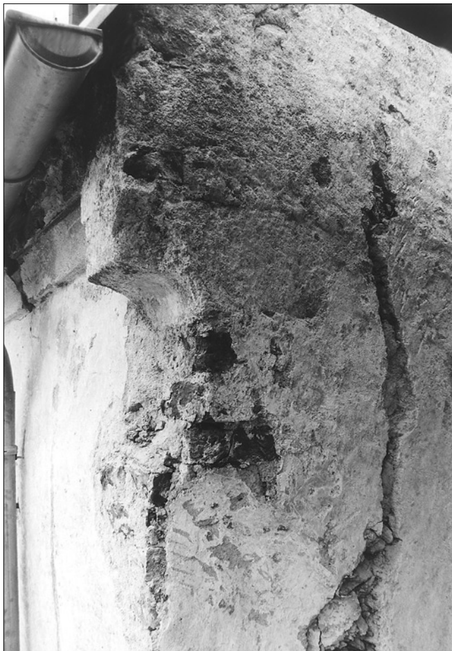
Obr. 9: Čížová, kostel sv. Jakuba Většího. Konzola pod přesahem paty střešního štítu na jihovýchodním nároží presbyteria.
