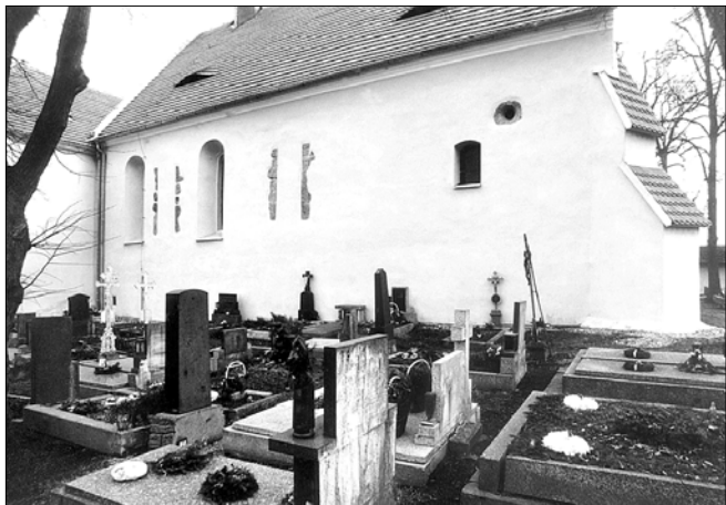
Obr. 11: Čížová, kostel sv. Jakuba Většího. Severní stěna lodi. Stav po opravě.
