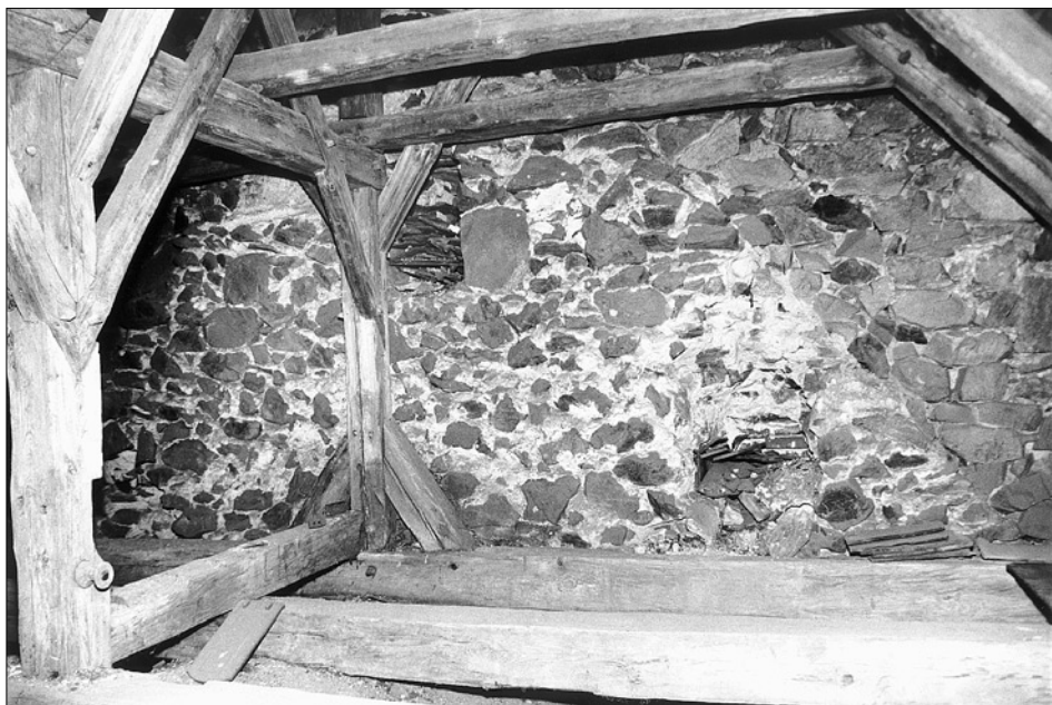
Obr. 7: Čížová, kostel sv. Jakuba Většího. Podkroví presbyteria. Pohled na východní střešní štít presbyteria. Dobře je viditelný rozdíl mezi zdivem původního nižšího štítu a jeho dodatečnou nadezdívkou.
