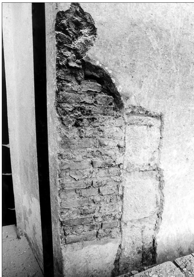
Obr. 8: Čížová, kostel sv. Jakuba Většího. Jižní stěna presbyteria. Horní část původního okna v době opravy omítek. Vlevo pravý bok špalety nynějšího okna.
