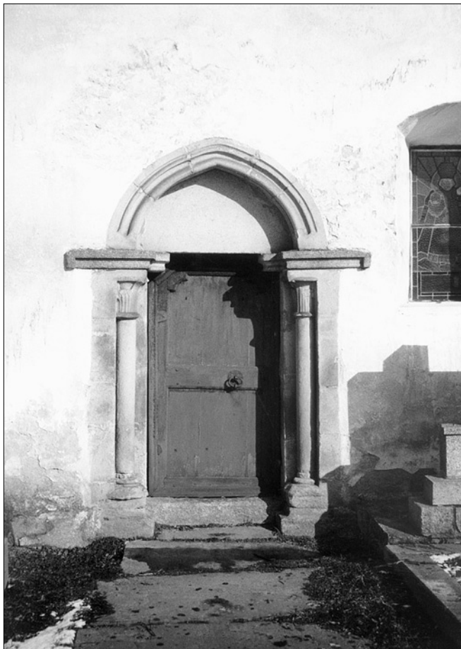
Obr. 6: Kostel sv. Kunhuty, raně gotický portál jižního vstupu do tzv. staré lodi.
