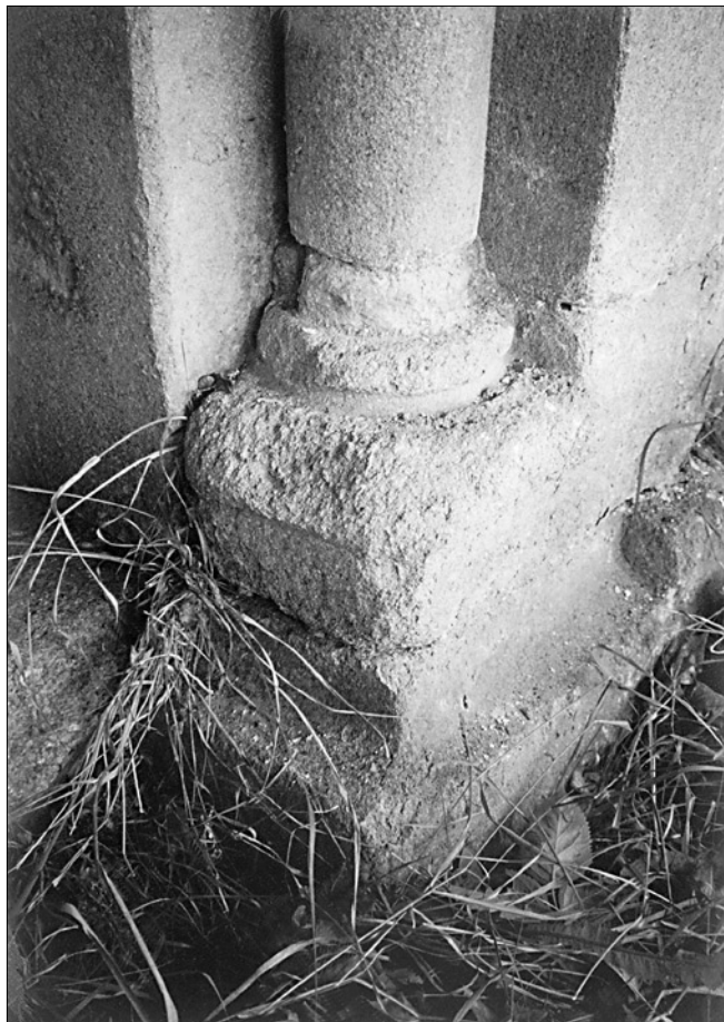
Obr. 7: Kostel sv. Kunhuty, detailní záběr na spodní část portálu jižního vstupu.
