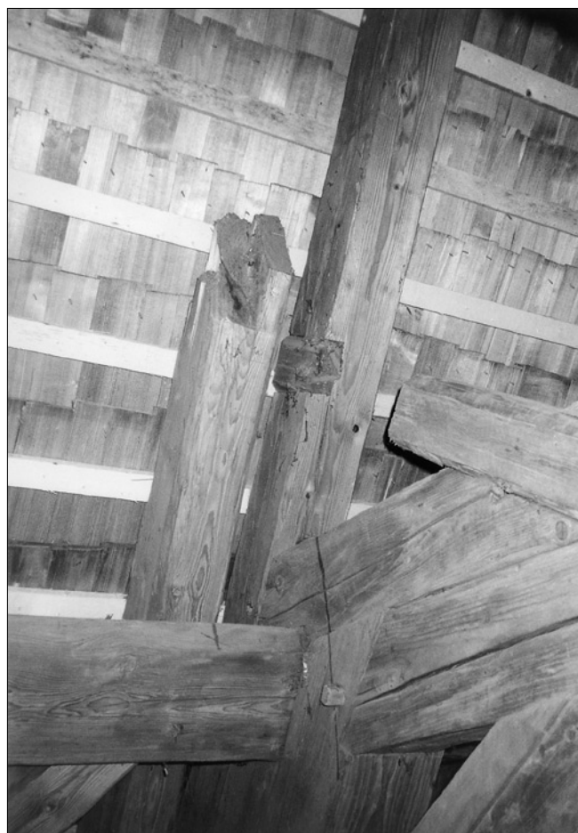
Obr. 18: Kostel sv. Kunhuty, krov nad starou lodí - v levé části snímku zápora původní stolice zvonové věže s dlabem, který zbyl po rohovém sloupku, napravo křížová vzpěra odříznutá při odstraňování podélné záporu sloupku.
