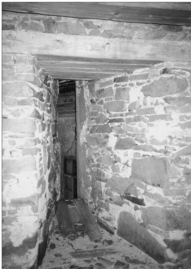
Obr. 5: Mirovice, okno 2. patra zvonice na severovýchodní straně.
