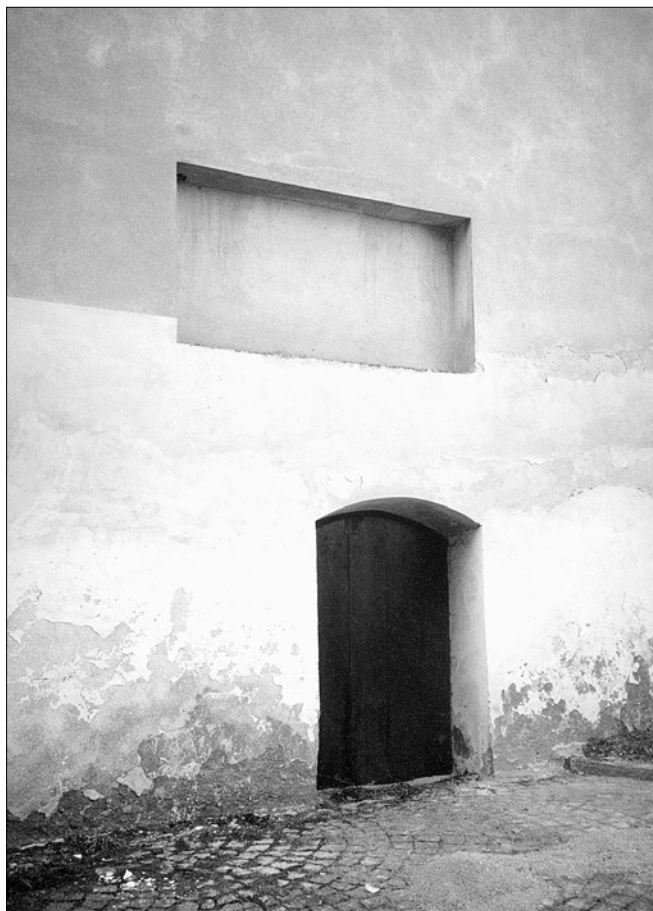
Obr. 4: Mirovice, vstup do zvonice a vpadlina nad ním.
