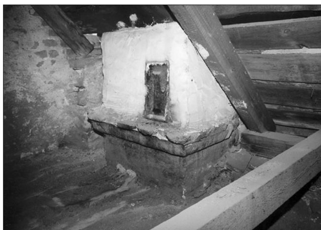
Obr. 9: Znojmo, Zelenářská č. 5, ukončení komína nad peronem v podkrovní sedlové střechy (foto D. Černoušková).
