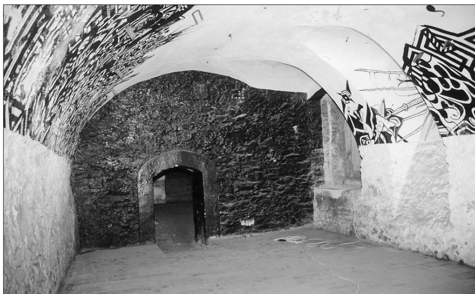
Obr. 3: Znojmo, Zelenářská č. 5, zadní sklep, vpravo ústí šíje s portálkem, pod klenbou zazdřený zbytek trámu. Stav v roce 2000 (foto D. Černoušková).
