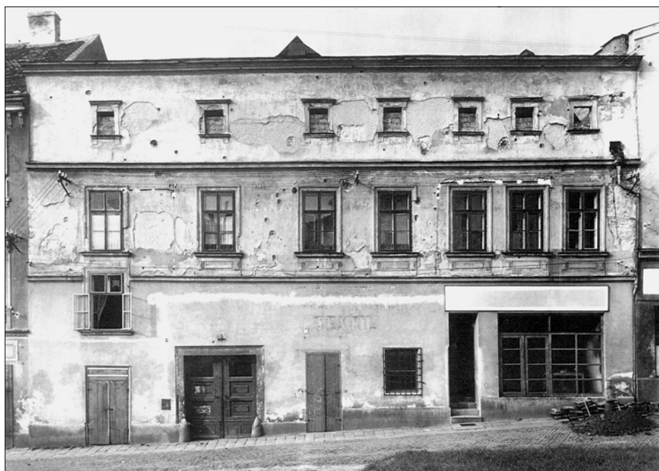
Obr. 1: Znojmo, Zelenářská č. 5, uliční průčelí před zřícením atiky v roce 1962 (Archiv SPÚ Brno).
