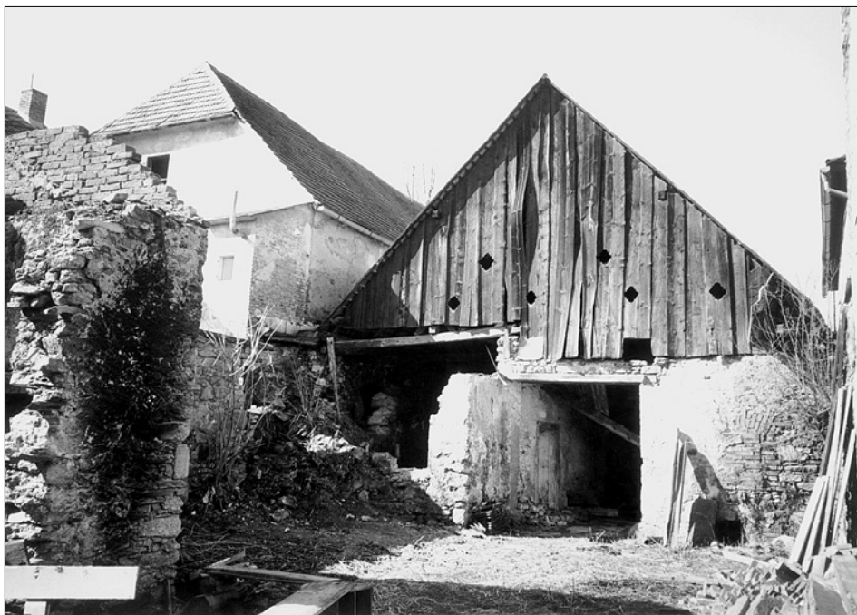
Obr. 7: Vyšší Brod. Prostředí dvora a dvorní průčelí domu čp. 30 s bedněným štítem v r. 1997.
