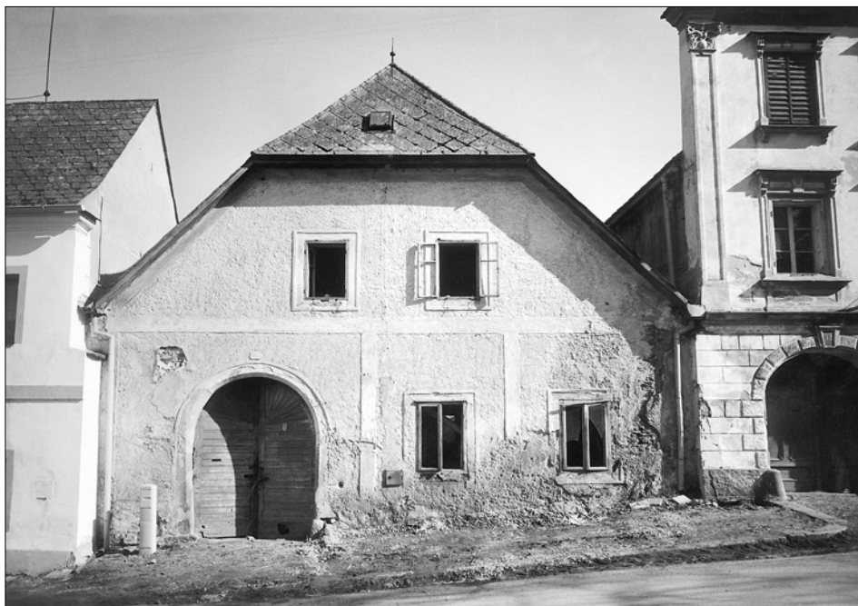
Obr. 2: Vyšší Brod. Průčelí domu čp. 30 a části domu čp. 31 k náměstí (stav r. 1997).
