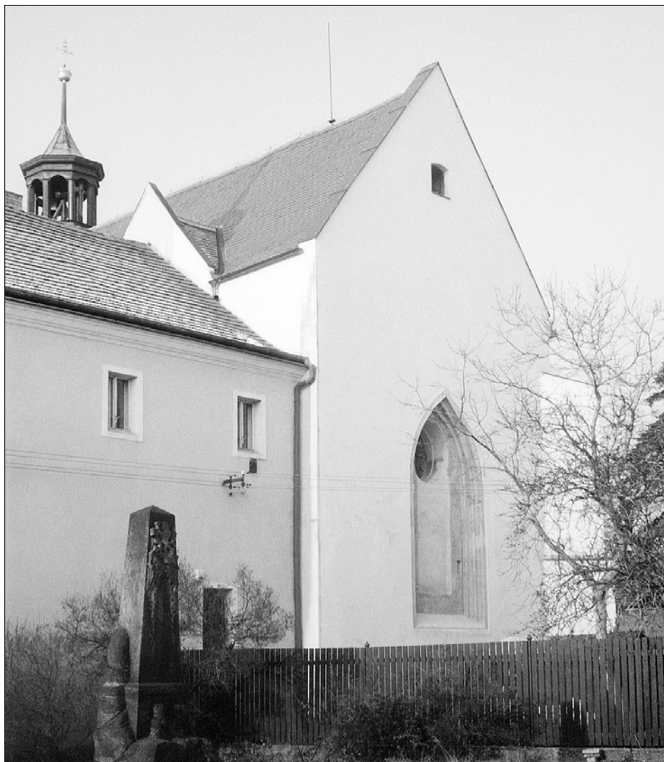
Obr. 8: Pšovka, bývalý augustiniánský klášter. Východní průčelí bývalého konventu s navazujícím průčelím kostela. Střecha konventu z 19. století, se starším štítem při kostele, gotické okno po obnově (příznána vnější část ostění).
