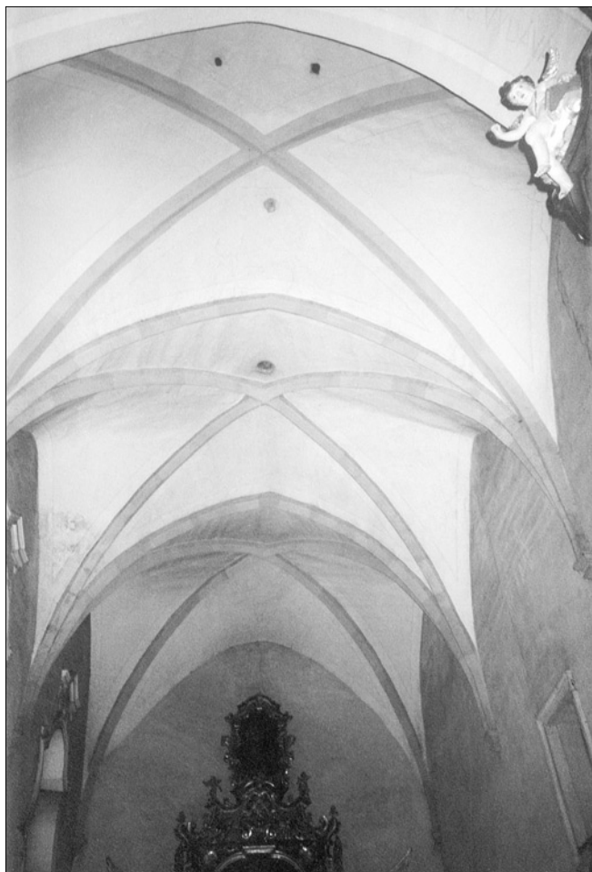
Obr. 23: Pšovka, bývalý augustiniánský klášter. Detail gotické, v baroku upravené klenby v presbytáři kostela sv. Vavřince.
