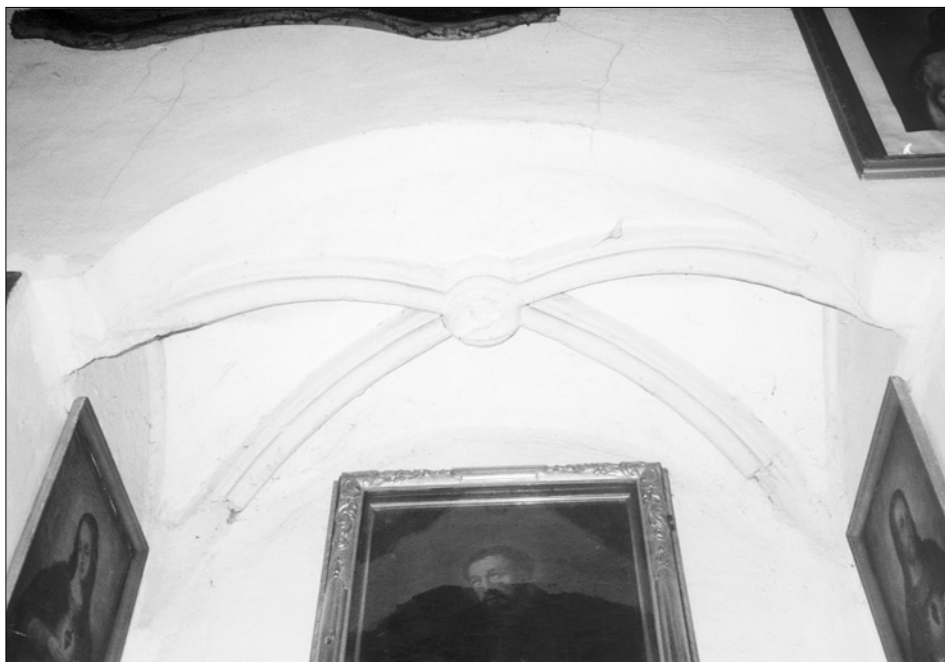
Obr. 28: Pšovka, bývalý augustiniánský klášter. Klenba v mladší nīce západní stěny sakristie.
