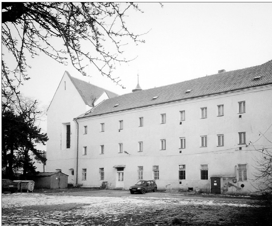
Obr. 9: Pšovka, bývalý augustiniánský klášter. Západní průčelí kostela s navazující barokní budovou konventu.
