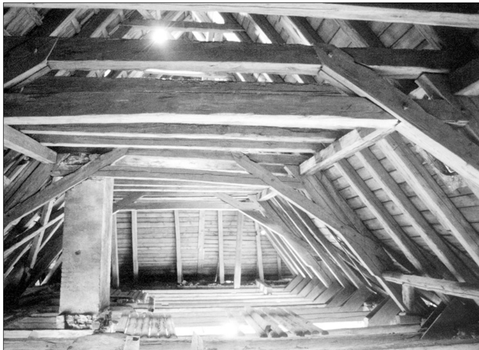
Obr. 25: Kuřivody, zámek. Renesanční krov nad západním křídlem, pohled k jihu.
