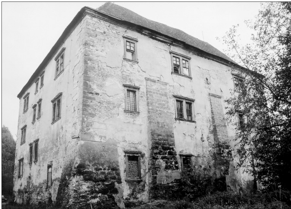
Obr. 3: Kuřivody, zámek. Celkový pohled od severozápadu. Armatura nároží a zřetelně odlišná struktura zdí-va ukazují na výšku zachovaných středověkých konstrukcí.
