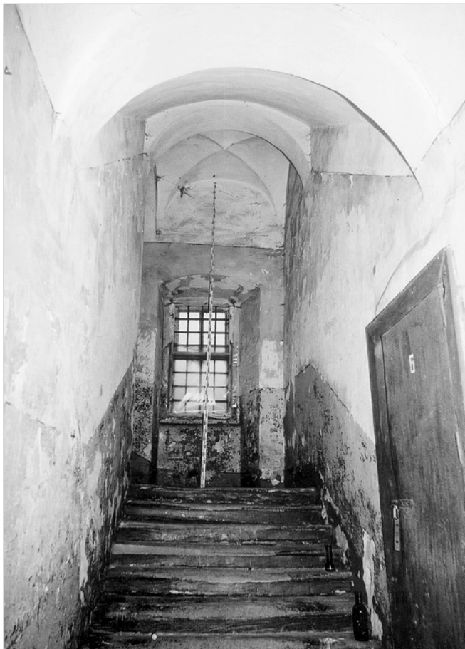
Obr. 20: Kuřivody, zámek. Schodiště z přízemí do prvního patra, nástupní rameno s pohledem k mezípodestě.
