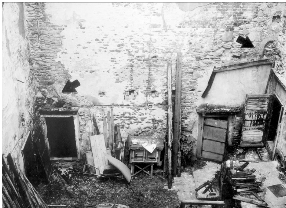
Obr. 14: Kuřivody, zámek. Přízemí nádvorní stěny západního křídla, někdejšího gotického paláce. Šipkami jsou označeny středověké kamenické články - vlevo druhotně osazený reliéfní panel s vimperkem a berkovským erbem, vpravo okénko.
