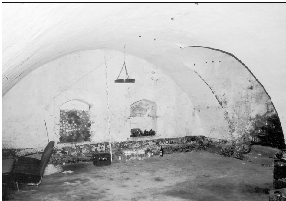
Obr. 19: Kuřivody, zámek. Polosuterénní místnost v jihozápadním nároží, zaklenutá nízkou valenou klenbou. Mezi klenbou a podlahou prvního patra je několik metrů vysoký nepřístupný prostor.
