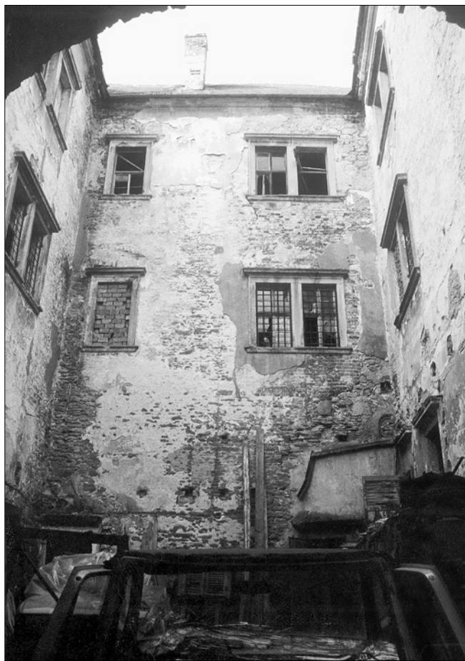
Obr. 13: Kuřivody, zámek. Celkový pohled do nádvoří od východu. Lomové zdivo z drobných kamenů ukazuje na rozsah zachovaných středověkých konstrukcí západního paláce.
