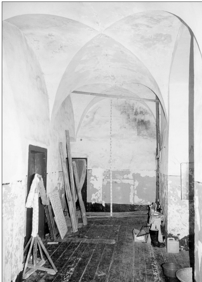
Obr. 21: Kuřivody, zámek. Chodba ve dvorním traktu západního křídla, klenutá renesanční hřebinkovou křížovou klenbou, pohled k severu. V severní čelní stěně vlevo dveře do rohové severozápadní místnosti, vpravo od nich zazděný příkládací portálek.
