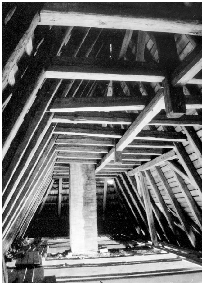
Obr. 24: Kuřivody, zámek. Renesanční krov nad jižním křídlem, pohled k východu.
