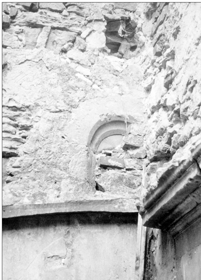
Obr. 16: Kuřivody, zámek. Nádvoří stěna západního křídla, zazděné gotické okénko ve stěně nejstaršího paláce, částečně překryté dvorní stěnou pozdně gotického severního křídla.
