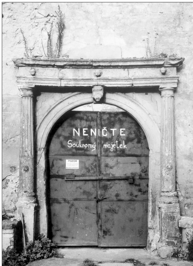
Obr. 30: Kuřivody, zámek. Renesanční vstupní portál z doby přestavby za Bohuchvala Berký z Dubé v prvních desetiletích 17. století. Nad římsou kladí byl dnes již zaniklý štítový volutový nástavec s erbem Bohuchvala Berký z Dubé a jeho ženy Kateřiny rozené Slavatovny z Chlumu.
