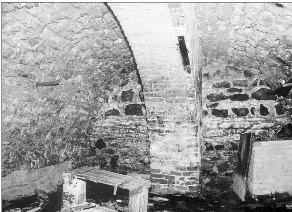
Obr. 17: Kuřivody, zámek. Západní ze dvou sklepních místností pod zvýšeným přízemím severního křídla. Místnost je zaklenutá pozdně středověkou kamennou valenou klenbou, pod kterou je druhotně vyklenut cihelný pas, vynášející střední vřetenovou zeď renesančního schodiště. Ve světlém pískovcovém zdivu stratigraficky nejstarší obvodové stěny jsou patrně vodorovně uložené sloupce tmavého čediče, sloužící snad jako armatura zdiva a izolace proti vodě.
