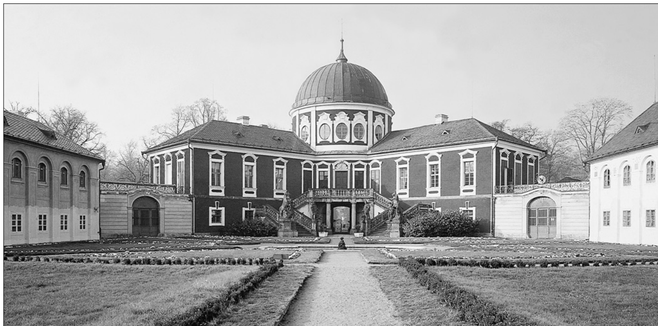
Obr. 2: Zámek Veltrusy, pohled na hlavní průčelí (foto V. Razím, 1999).
