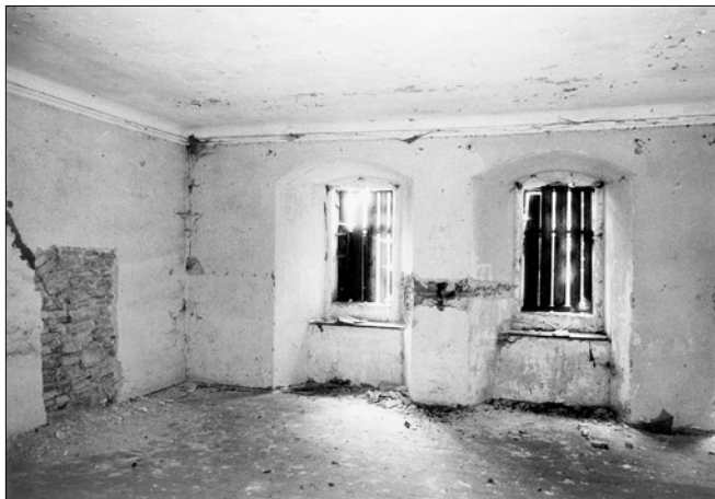
Obr. 14: Vraclav, dům čp. 115. Jihovýchodní kout sálu zřízeného v patře bývalé lodi kostela sv. Václava. Vlevo je východní stěna s částečně odhaleným zdivem triumfálního oblouku. V pilíři zdiva mezi oběma okny byla zjištěna západní hrana vnitřní špalety původního okna (foto J. Sommer, 2001).
