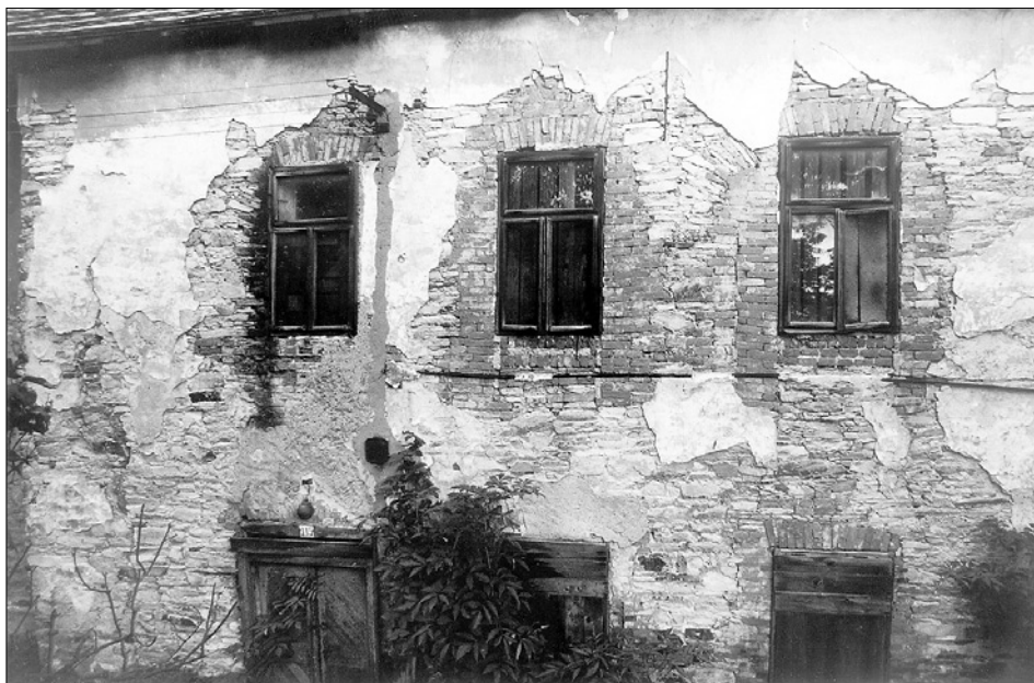
Obr. 3: Vraclav, čp. 115. Pohled na jižní průčelí centrální části budovy od jihovýchodu (foto J. Sommer, 2001).
