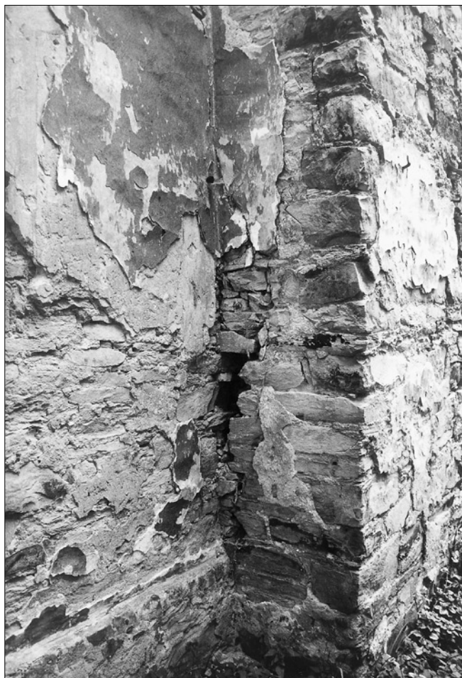
Obr. 11: Vraclav, dům čp. 115. Detail jihozápadního nároží bývalé lodi kostela sv. Václava. Vlevo jižní stěna věže (foto J. Sommer, 2001).
