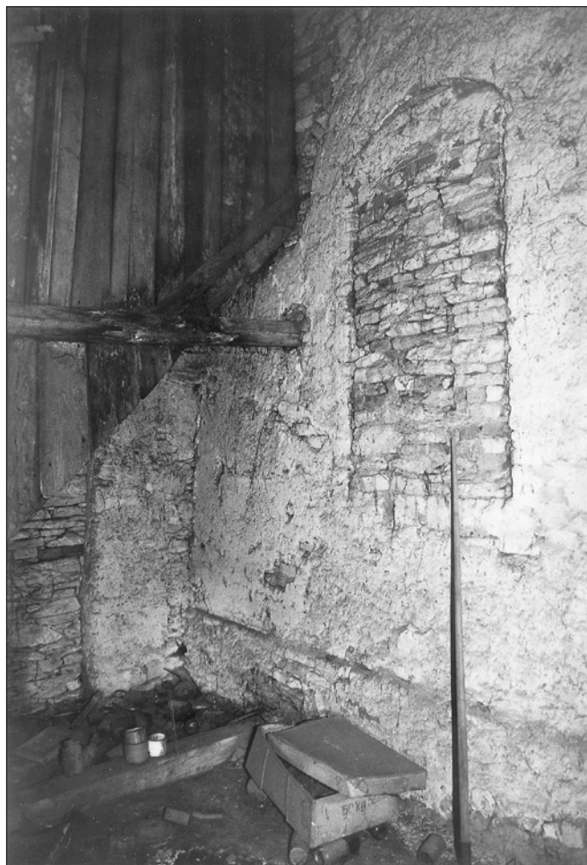
Obr. 12: Vraclav, dům čp. 115. Severní stěna patra věže v pohledu z podkroví dodatečného přístavku. Vlevo pod dřevěným schodištěm je viditelné severozápadní nároží bývalé lodi (foto J. Sommer, 2001).
