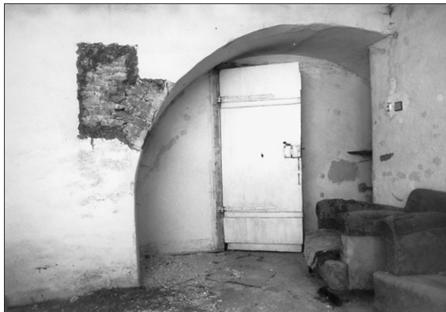
Obr. 16: Vraclav, dům čp. 115. Záklenek triumfálního oblouku zrušeného kostela sv. Václava v pohledu z místnosti v patře východního křídla domu. Sondou v omítkách základenu je odhaleno cihlové zdivo základenu a navazující lomové zdivo východní stěny bývalé lodi (foto J. Sommer, 2001).
