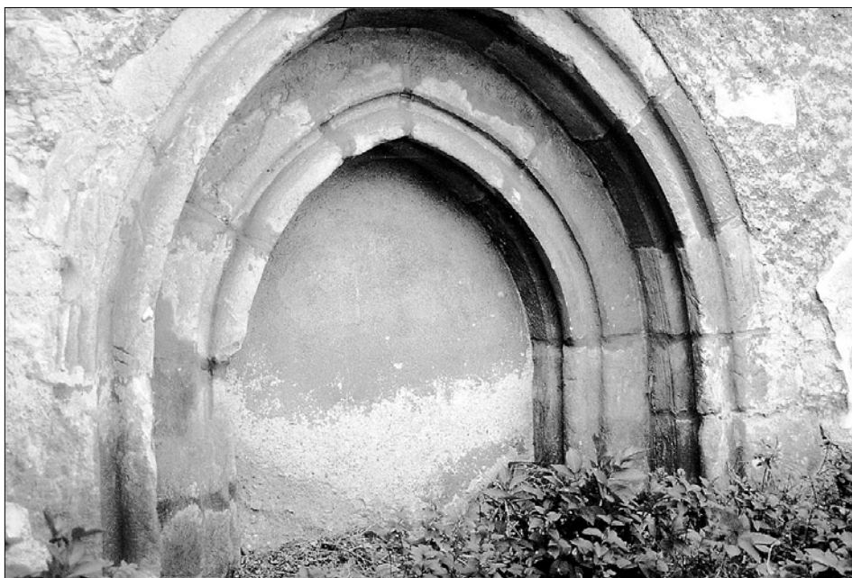
Obr. 16: Lounky, kostel sv. Mikuláše, severní portál do lodi (foto P. Kroupa).
