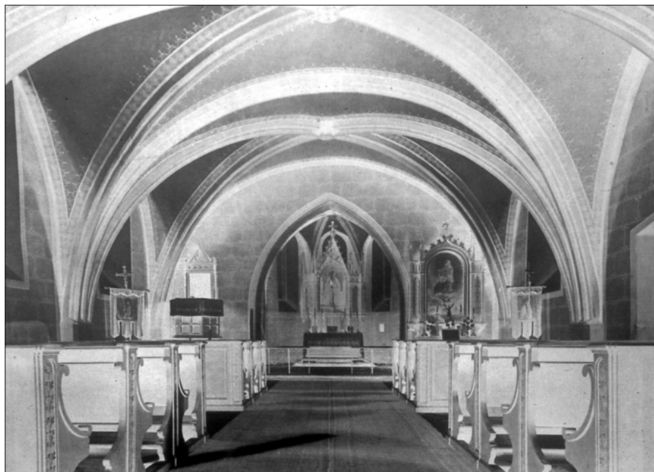
Obr. 4: Velký Pálec, kostel Narození P. Marie, interiér, pohled k východu, historický stav (reprofoto Hana Floriánová SPÚŠČ).
