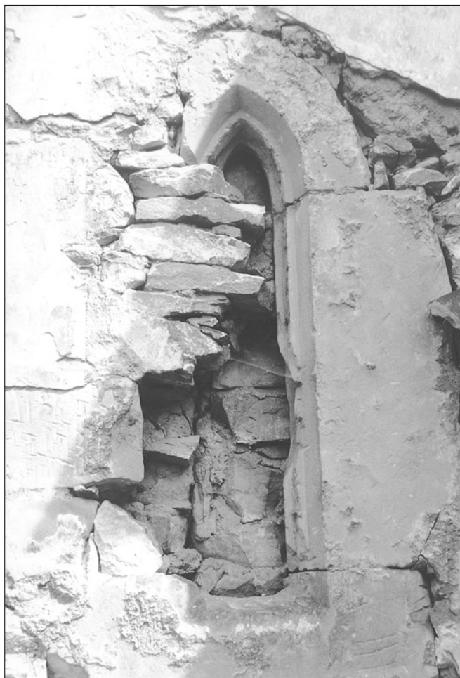
Obr. 17: Lounky, kostel sv. Mikuláše, jižní průčelí lodi, východní zazděné okno (foto P. Kroupa).
