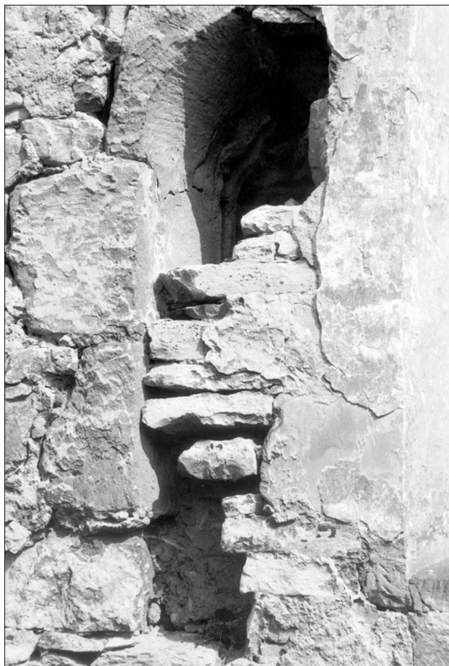
Obr. 18: Lounky, kostel sv. Mikuláše, jižní průčelí lodi, západní zazděné okno (foto P. Kroupa).
