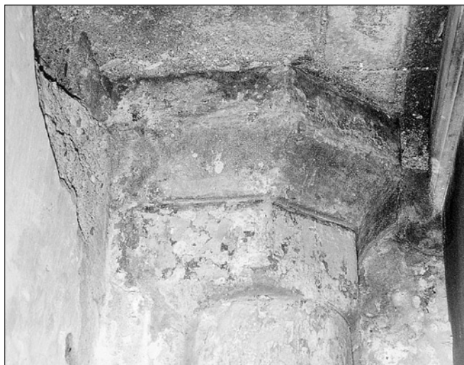
Obr. 13: Loučky, kostel sv. Mikuláše, patka přípory v severozápadním koutě lodi. (foto P. Kroupa)
