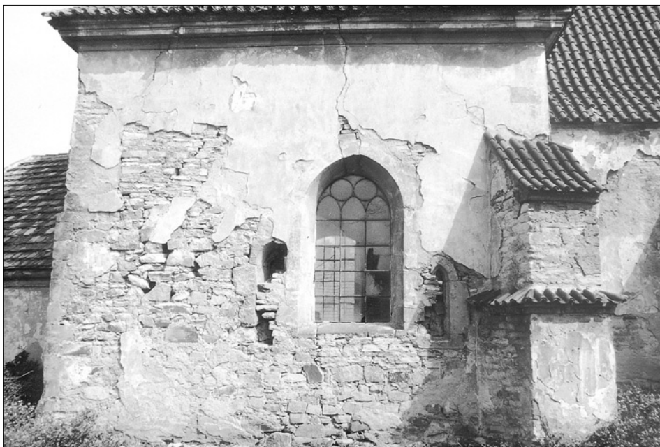
Obr. 15: Lounky, kostel sv. Mikuláše, jižní průčelí lodi (foto P. Kroupa).
