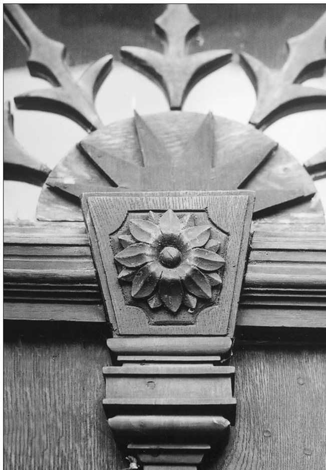
Obr. 16: Železnice, dům čp. 181 (dnes Muzeum). Levé vstupní dveře (do domu), detail hlavice klapačky.
