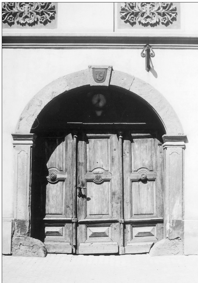
Obr. 8: Železnice, dům čp. 19. Vrata jednoho z nejvýznamnějších klasicistních domů ve městě, s charakteristickými kruhovými terčíky na vodorovných prvcích rámové konstrukce.
