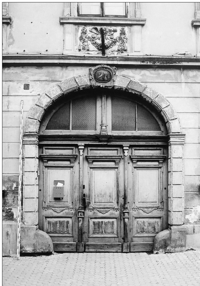
Obr. 10: Železnice, dům čp. 27. Vrata domu z doby krátce po roce 1842, jednoho z posledních klasicistních objektů ve městě. Vrata v detailech již ohlašují nastupující období historismu.
