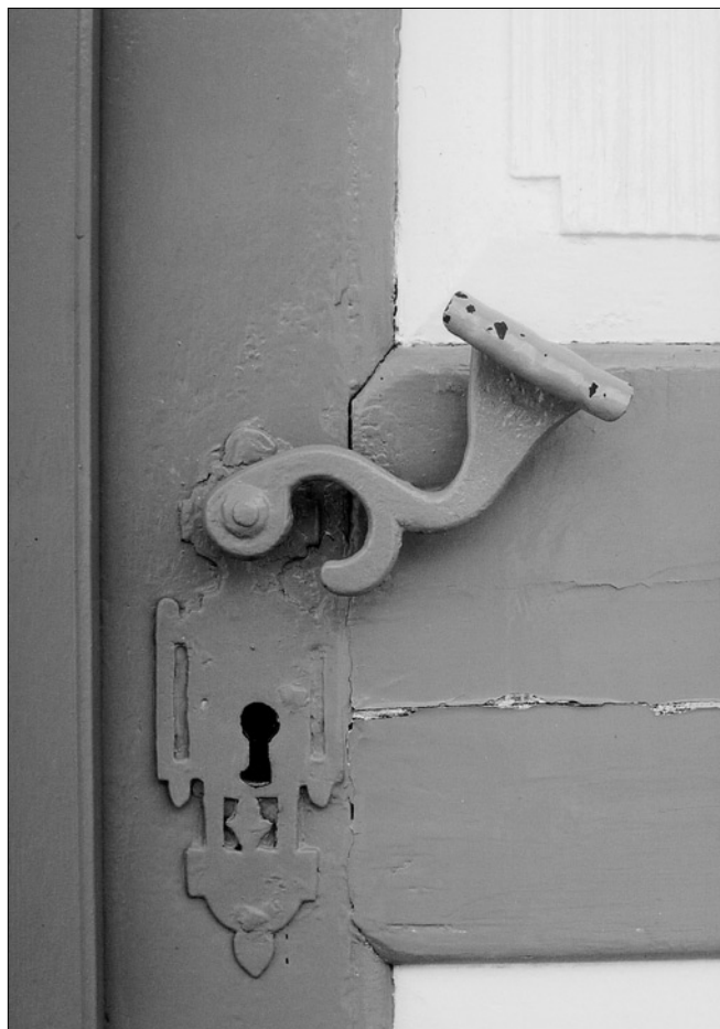
Obr. 17: Železnice, dům čp. 191. Vstupní dveře, detail klasicistní kované kliky s prolamovanou podložkou.
