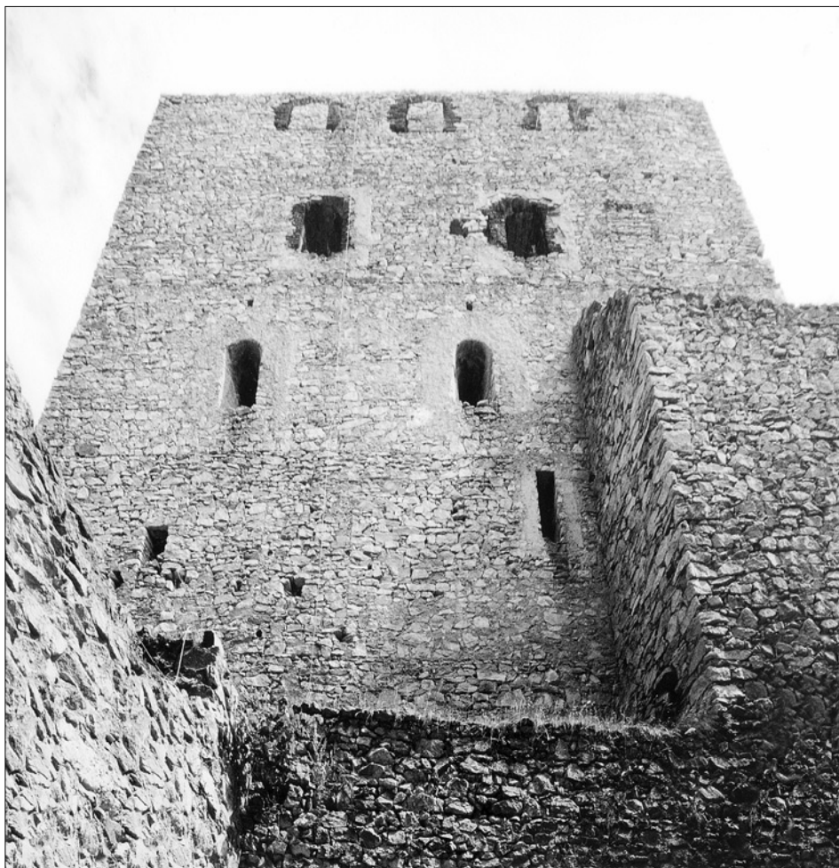
Obr. 1: Rabí (okres Klatovy) obytná věž jádra hradu, jihozápadní průčelí.
