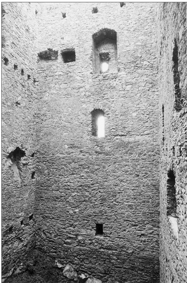
Obr. 6: Rabí, obytná věž jádra hradu, interiér. Pohled na jihovýchodní stěnu se stopami vertikálního dělení budovy a okenními otvory. Uprostřed půlkruhově zaklenuté okénko 2. patra.
