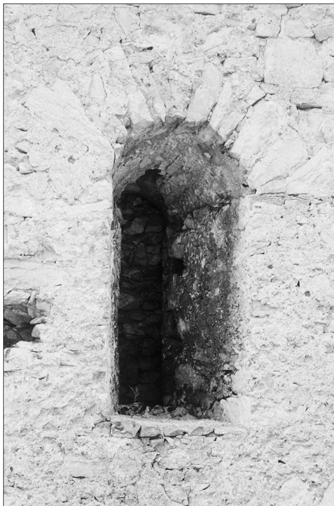
Obr. 5: Rabí, obytná věž jádra hradu, detail okénka 2. patra severovýchodního průčelí (srov. obr. 4). V nejužším místě okenního otvoru patrně zbyly zániklé mříže.
