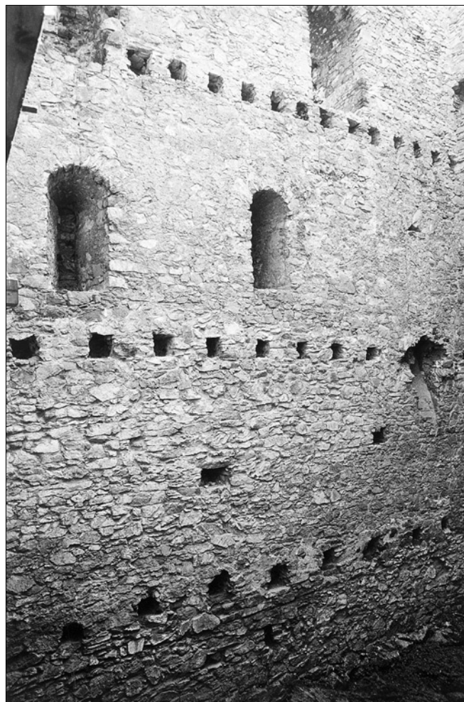
Obr. 7: Rabí, obytná věž jádra hradu, interiér. Pohled na severovýchodní stěnu od západu. Kapsy stropních trámů přízemí a dvou pater, ve druhém patře dvě půlkruhově sklenutá okénka s rozdílnou výškovou úrovní parapetů, třetí okénko upravo zazděno (snímky V. Razím, 2001).
