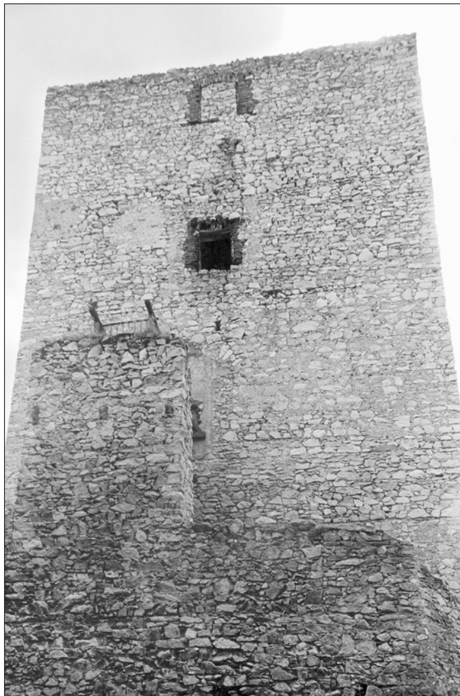
Obr. 3: Rabí, obytná věž jádra hradu, severozápadní průčelí. V popředí pílň můstku k dodatečně zřízenému vstupu do 2. patra. Vpravo od pílře zazděné okénko s půlkruhovým záklenkem.
