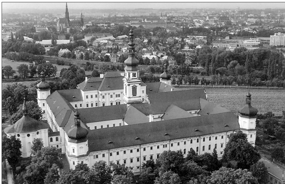
Obr. 1: Hradisko u Olomouce, letecký pohled na kanonii od severovýchodu (foto J. Freit).
