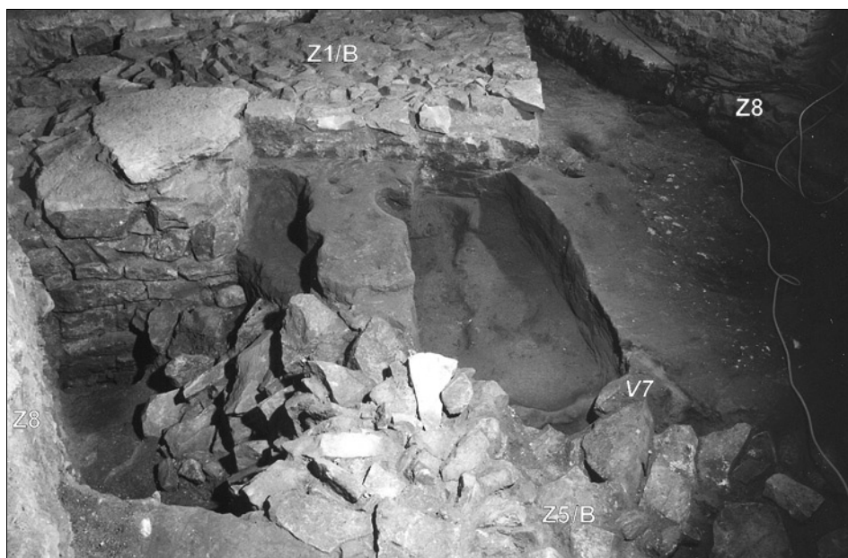
Obr. 4: Praha 1 – Staré Město, Na Zábradlí čp. 205/I. Nálezová situace v sektoru B s mohutným základem kvadratické lodi románské centrály s náběhem na jižní apsidu (Z1) a torzem základu apsidy staršího kostela (Z5) porušující železářský objekt (V7). Mezi zdmi vypreparované hrobové jámy. Pohled od východu (foto K. Kozák, 2001).
