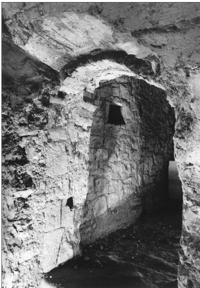
Obr. 2: Praha 1 – Staré Město, Michalská čp. 438/I. Situace jižního boku vstupního otvoru a zděné vstupní šije. Stav před rekonstrukcí v r. 2001. Pohled od východu (foto K. Fínek).
