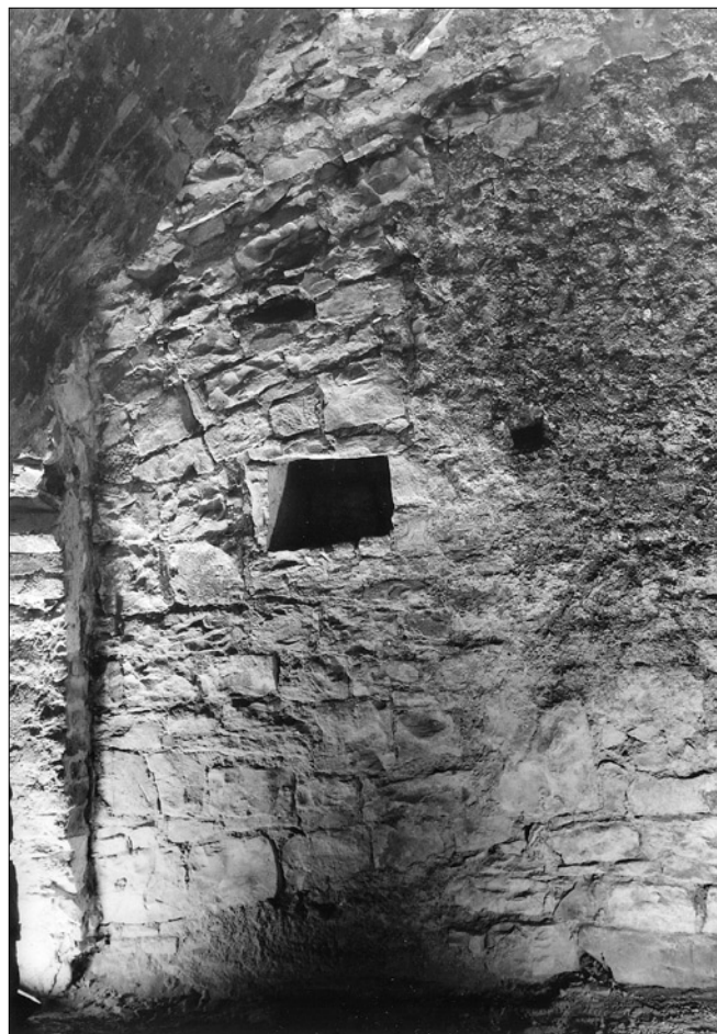
Obr. 3: Praha 1 – Staré Město, Michalská čp. 438/I. Jižní bok původní vstupní šije s odkládací nikou a šikmo zděnou horní částí. Stav před rekonstrukcí v r. 2001. Pohled od severu (foto K. Fínek).
