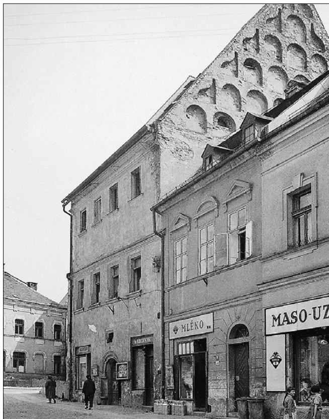
Obr. 3: Horní Slavkov, dům čp. 52, Nidermanův, postavený roku 1536 s bočním štítem, členěným půlkruhově zakončenými níkami. Dům se sedátkovým portálem (foto z roku 1960).
