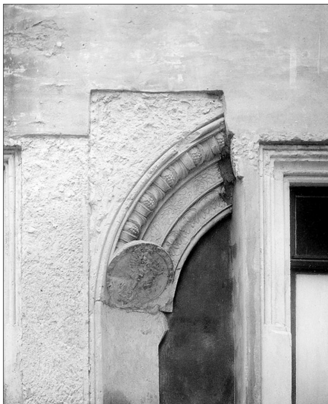
Obr. 25: Pirna (Sasko), dům na Kirchenplatz, severně od městského kostela, po roce 1540.
