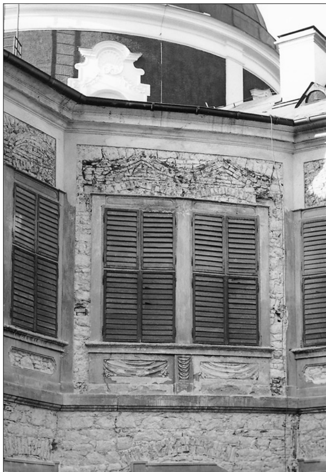
Obr. 7: Veltrusy (okres Mělník) zámek. Okna na východní straně patra střední části zámku. Nad okny je dobře patrná konstrukce původních nadokenních říms, nad nimiž je z opuky vyzděn segmentový vynášecí oblouk.
