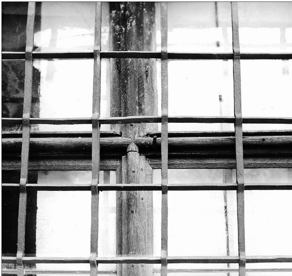
Obr. 9: Veltrusy zámek. Detail okenního rámu v přízemí na východní straně střední části zámku. Rám zřejmě pochází z doby výstavby zámku. Zasklení je asi pozdější.
