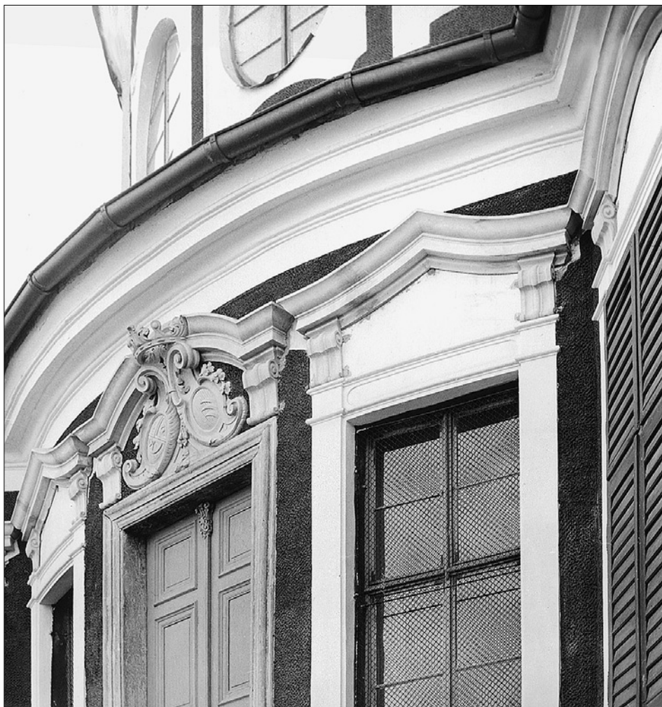
Obr. 11: Veltrusý zámek. Detail patra střední části zámku na severní straně po osazení nových prefabrikátů nadokenních říms, před provedením konečné povrchové úpravy (všechny snímky J. Sommer, 1991).
