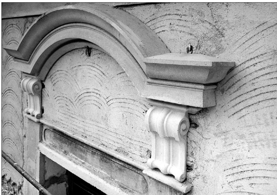
Obr. 10: Veltrusy zámek. Detail nově osazeného prefabrikátu suprafenestry patra.
