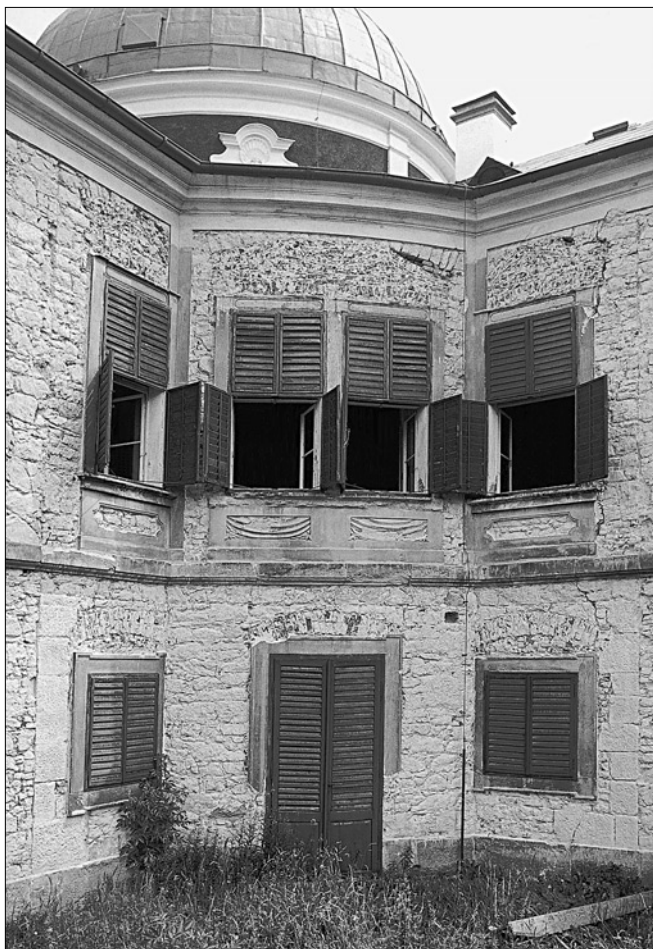
Obr. 5: Veltrusy zámek. Pohled na střední část od západu po sejmutí omítek. Nad okny patra jsou viditelné pozůstatky osekáných říms a nad nimi segmentové vynášecí pasy.
