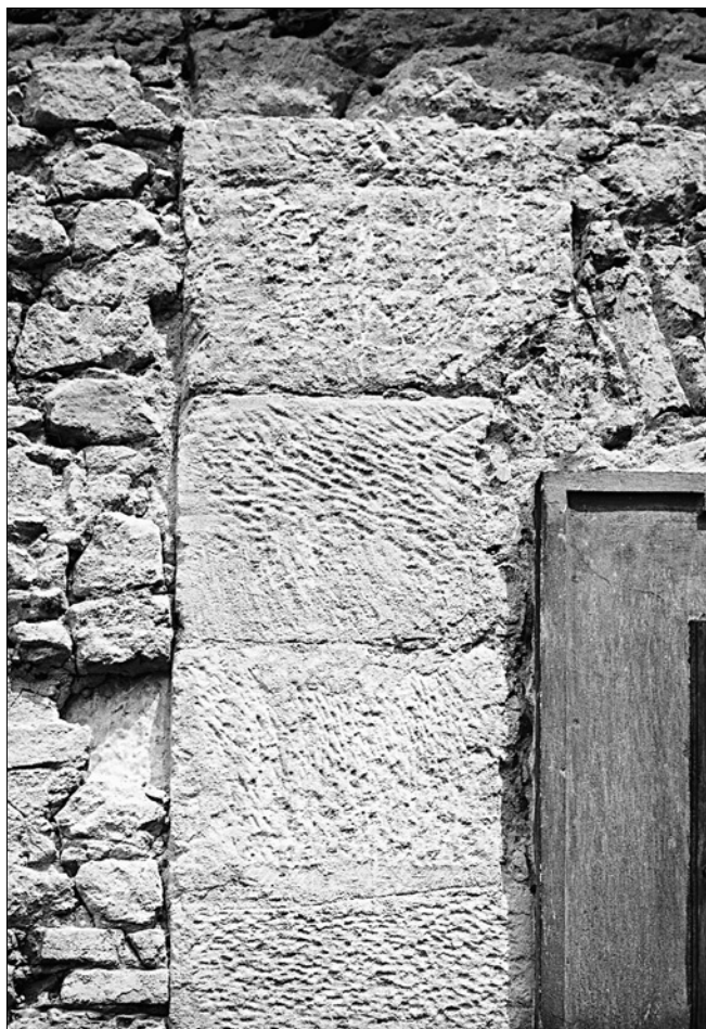
Obr. 6: Veltrusy zámek. Detail jihozápadního průčelí severozápadního křídla v místě původního nároží kratšího křídla. V místě narušení mladšího zdiva (vlevo) je patrné odsazené zaoblení nároží.
