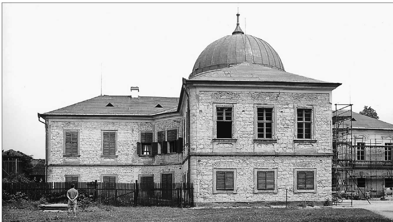
Obr. 4: Veltrusý zámek. Pohled od jihozápadu po úplném odstranění omítek. Vpravo je částečně patrné jihozápadní průčelí jihovýchodního křídla s nově osazenými suprafenestrami.
