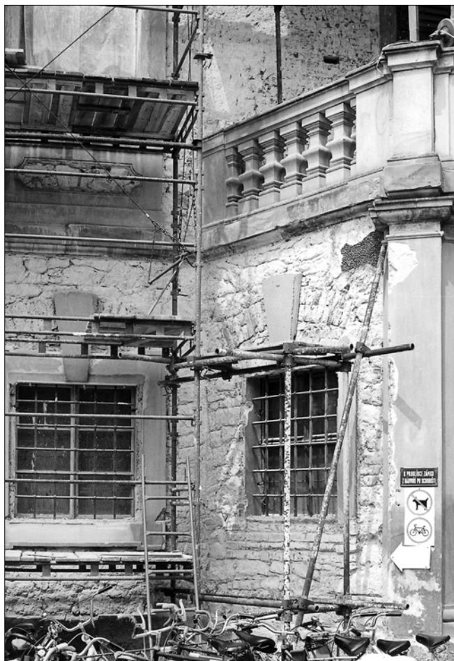
Obr. 8: Veltrusy zámek. Detail terasy na jižní straně zámku a okno v přízemí jihozápadního křídla. Nad okny přízemí jsou osazeny nové prefabrikované klenáky. Vpravo nahoře je nad zábradlím terasy patrný úsek cihlového zdiva, za nímž původně probíhal komínový průduch; nyní je v těchto místech v interiéru výklenek.
