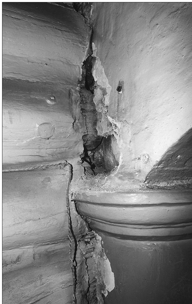
Obr. 11: Louny, dům čp. 57, detail z jihovýchodního kouta velké světnice – východní roubená stěna z pozdně gotické výstavby v kontaktu s jižní průčelní stěnou, přezděnou při pozdně renesanční přestavbě (hlavice sloupkového motivu s výběhem záklenku okenní níky). V sondě byla patrná někdejší existence roubené vazby a stopy její pozdější likvidace.
