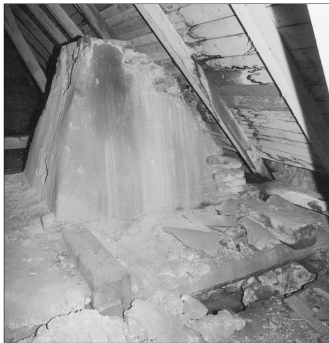
Obr. 20: Louny, dům čp. 57, ubouraná horní část dymníkového tělesa, usazená na trámovém věnci, v podkroví východní části domu. Zaměření, kresby půdorysů a portálů provedli M. Prchal a K. Kroulíková, řez domem vynesl a nakreslil J. Pešta, kresbu stropního trámu a fotografie pořídil J. Škabrada.
