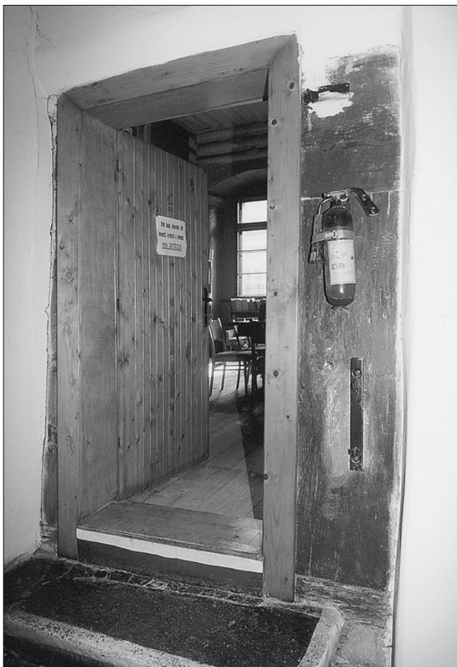
Obr. 8: Louny, dům čp. 57, vstup do velké roubené světnice s dochovanými částmi původního pozdně gotického dřevěného portálu – širokou pravou stojkou a vysokým překladem (spára mezi oběma díly probíhá za horním koncem hasičho přístroje).
