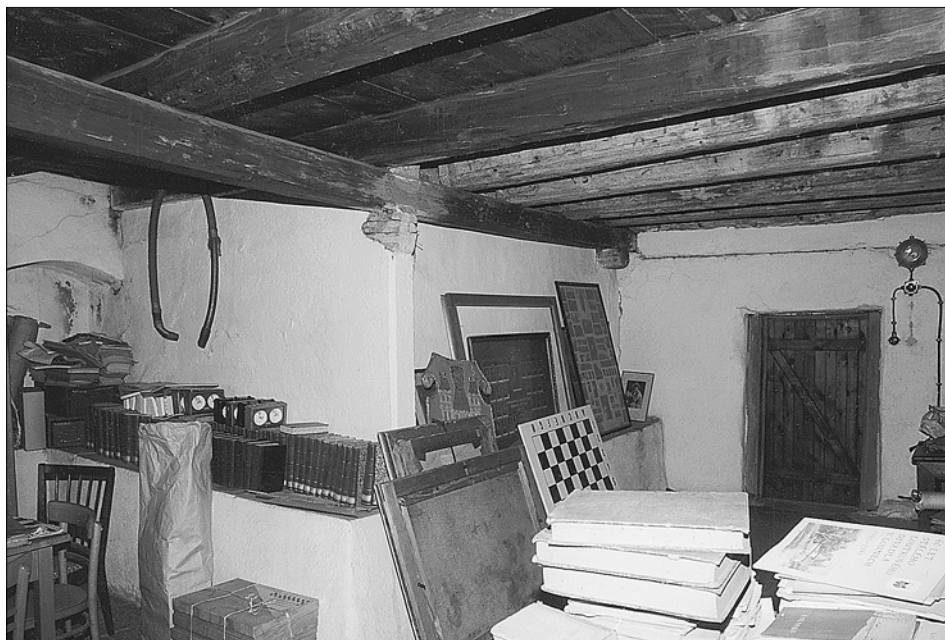
Obr. 19: Louny, dům čp. 57, místnost s trámovým stropem ve 2. patře, jejímž koutem prochází část dymníkového tělesa nad někdejší kuchyní ve východní části 1. patra. Dymník, fungující jako vyhřívací zařízení, byl vybaven obvodovou zděnou lavicí s dlaždicovým pokryvem.
