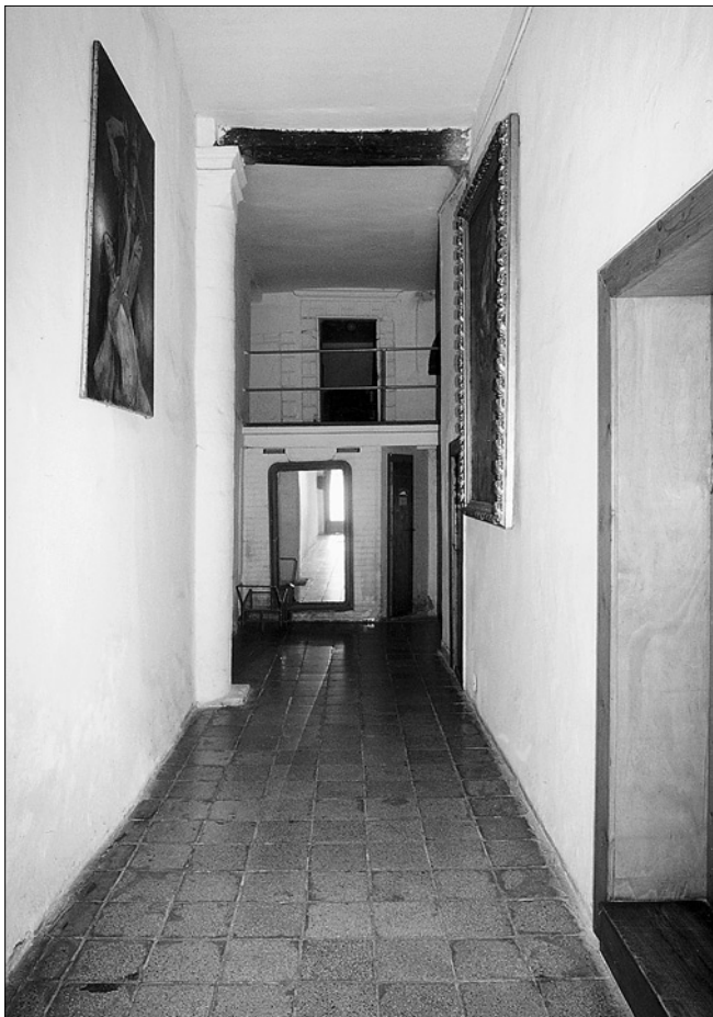
Obr. 14: Louny, dům čp. 57, pohled od vstupu do domu chodbou, vydělenou z velkého síňového prostoru v západní části přízemí. Vlevo při stěně vysoký polosloup, na který dosedá viditelný průvlak pod trámovým stropem s mladším omítaným podhledem. V průhledu nahore na galerii renesanční bosované portály (obr. 15).
