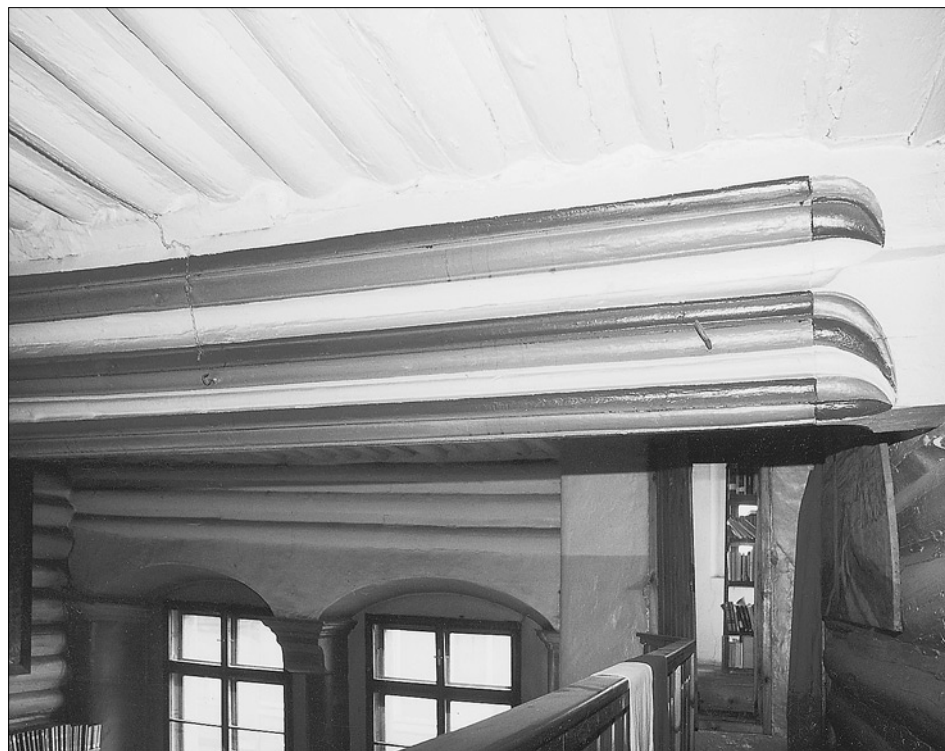
Obr. 12: Louny, dům čp. 57, detail stropu s bočním pohledem na profilaci a její výběh u západní stěny. V průhledu je vlevo renesančně přezděná průčelní stěna se slepou okenní arkádou a vpravo konec galerie se vstupem do místnosti ve druhém patře arkýře.
