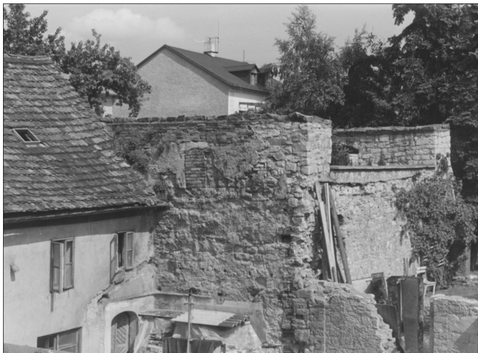
Obr. 10: Louny, velká parkánová bašta za domem čp. 136 na jihozápadní straně města, pohled od západu. Vpravo dodatečná uzavírací zeď na místě odbouraného dvoubokého závěru bašty, vlevo dům čp. 187. V horní části západní zdi bašty zazděné okno, které bylo zřízeno na místě střelny (foto V. Razím, 1997).
