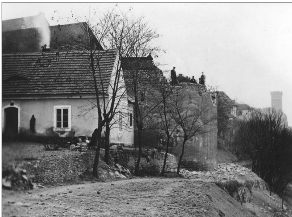
Obr. 20: Louny, velká bašta na severovýchodním nároží vnější hradby v pohledu od východu. Stav v průběhu bourání horní části stavby. Dobře jsou patrné střílny a celoplošná omítka. Snímek kolem roku 1900 (SÚPP Praha).
