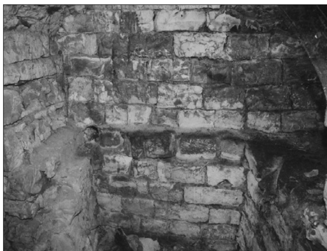
Obr. 25: Louny, velká bašta na severovýchodním nároží vnější hradby. Východní palebná komora v pohledu od jihu. Vpravo nika dvojice střílen, vlevo stěna se vstupem a s lůžkem zaniklého trámku, uprostřed severní stěna s vodorovným ústupkem v úrovni parapetu střílnové niky a trámku (foto V. Razím, 2002).
