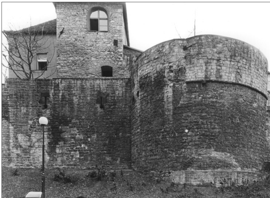
Obr. 17: Louny, část vnější hradby na severní straně města v pohledu od Ohře. Vpravo jedna z půlkruhových bašt, vlevo úsek kurtiny se dvěma velkými klíčovými střelnami. V pozadí dům čp. 72 (foto V. Razím, 1997).
