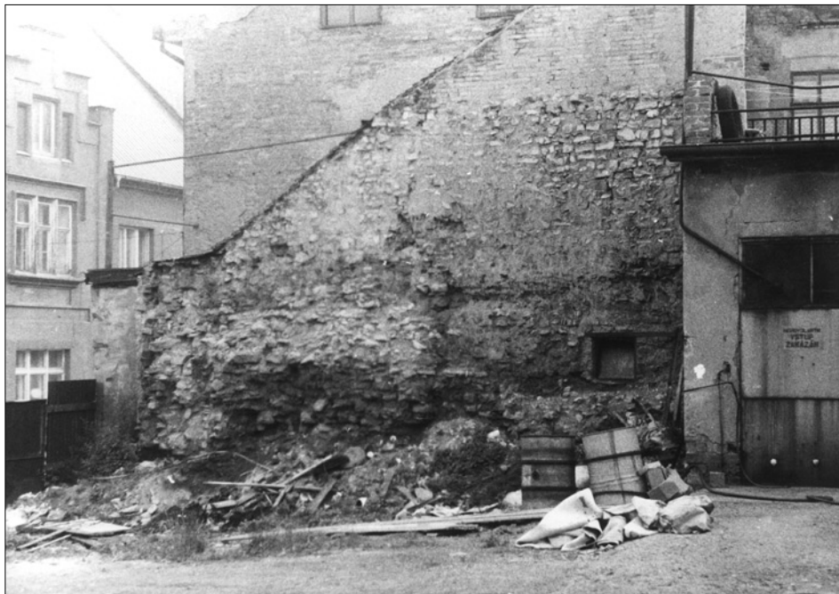
Obr. 8: Louny, zbytek východní obvodové zdi zbořeného domu čp. 144, odstraněný v letech 1991–1992. Pohled od západu. Je velice pravděpodobné, že šlo o relikt hlavní hradby v jižním sousedství Žatecké brány (srov. obr. 6/4; foto V. Razím, 1987).
