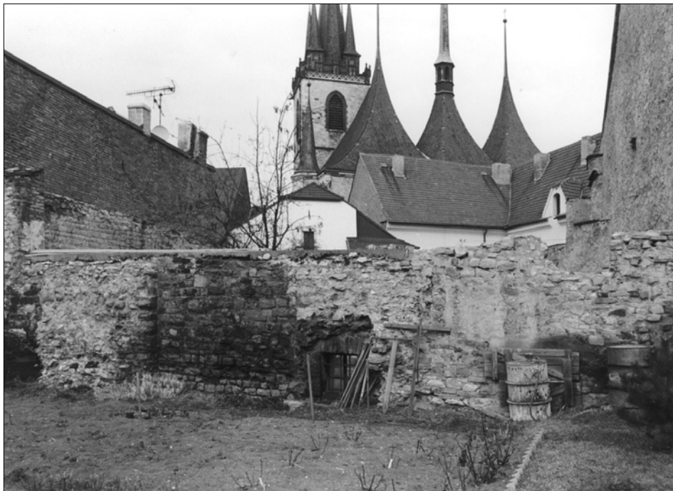
Obr. 9: Louny, relikt hlavní hradby (vlevo zbytek věže?) za domem čp. 137, pohled z parkánu. V pozadí farní kostel sv. Mikuláše (foto V. Razím, 1997).
