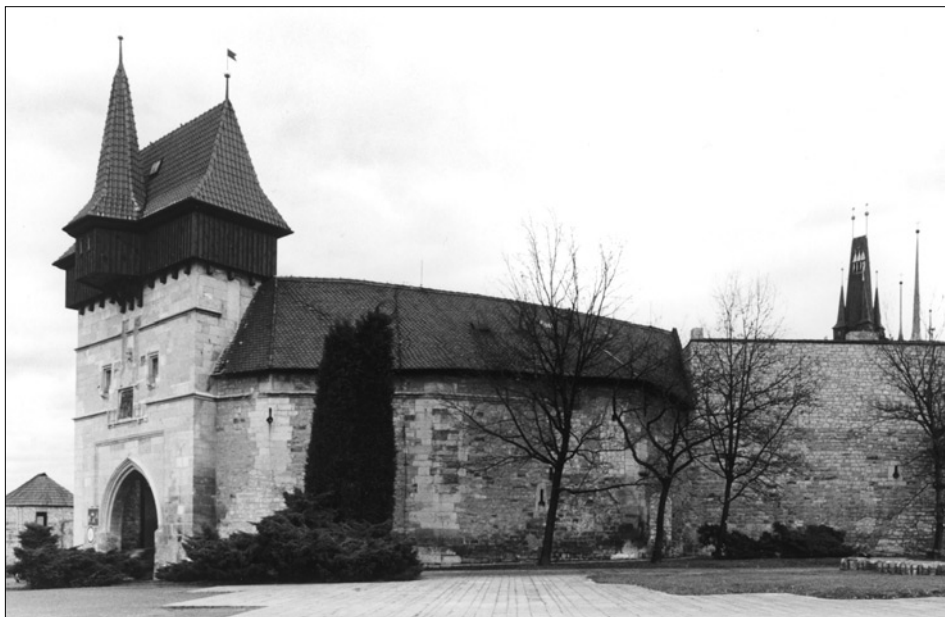
Obr. 35: Louny, Žatecká brána s vnějším barbakánem. Celkový pohled od jihozápadu. Na boční straně brány v úrovni 2. patra zazděný vstup, původně zřejmě vedoucí do podstřeší krytého ochozu plášťové zdi barbakánu (foto V. Razím, 1998).
