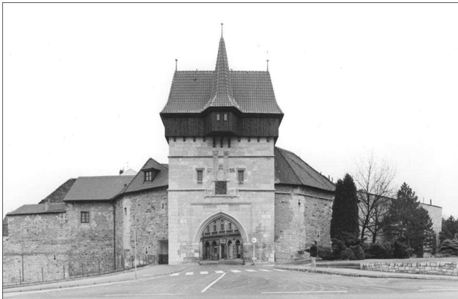
Obr. 34: Louny, Žatecká brána s vnějším barbakánem. Celkový pohled od západu (foto V. Razím, 1998).
