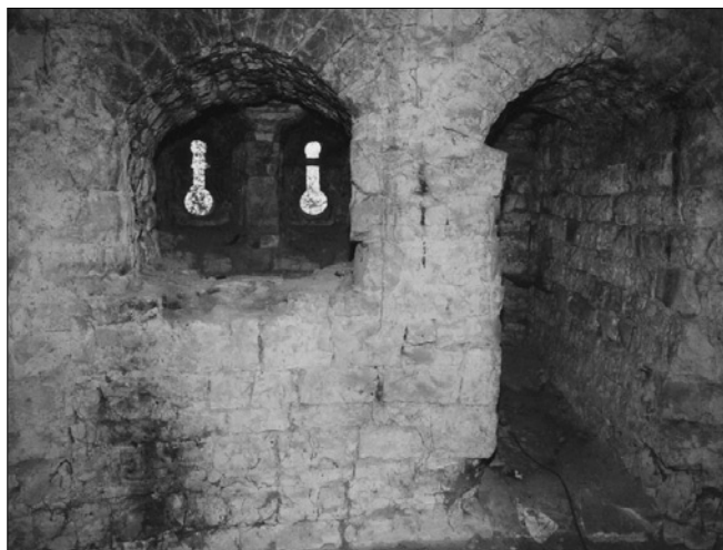
Obr. 23: Louny, velká bašta na severovýchodním nároží vnější hradby. Průhled z někdejšího hlavního prostoru přízemí do severní palebné komory. Vpravo vchod, vlevo okenní otvor do komory, v pozadí dvojice střílen s fragmentem horní dřevěné přičle pro zaklesnutí hákovice (foto V. Razím, 2002).
