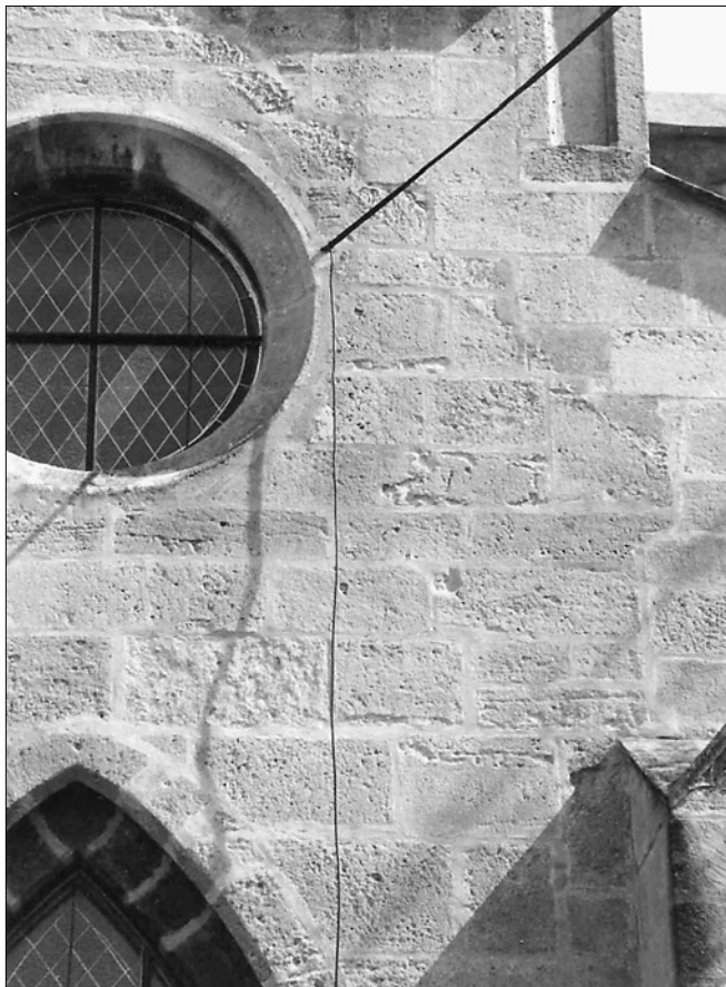
Obr. 8: Sedlec, bývalý cistercký chrám Nanebevzetí Panny Marie; detail západní fasády jižní boční lodi. Kamenné zdivo s patrným švem gotického stavu (foto autor).
